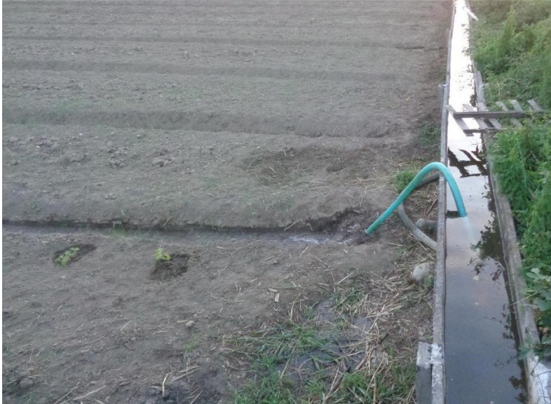
Εικόνα 18. Τιμεντένιος τριτεύοντας αγωγός και διάταξη με σίφωνα για την επιφανειακή άρδευση
