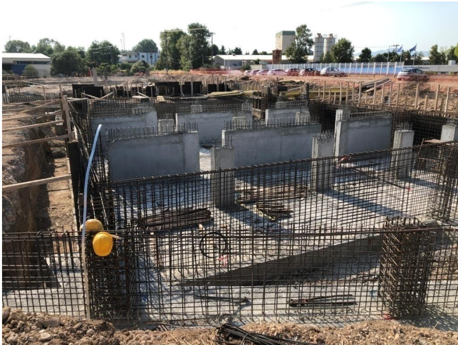
Εικόνα 4. Θεμελίωση από οπλισμένο σκυροδέμα
