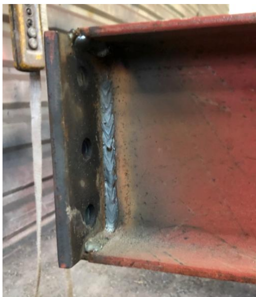
Εικόνα 17. Εξωραφή δοκαριού IPE 200 του μεταλλικού σπιτιού
