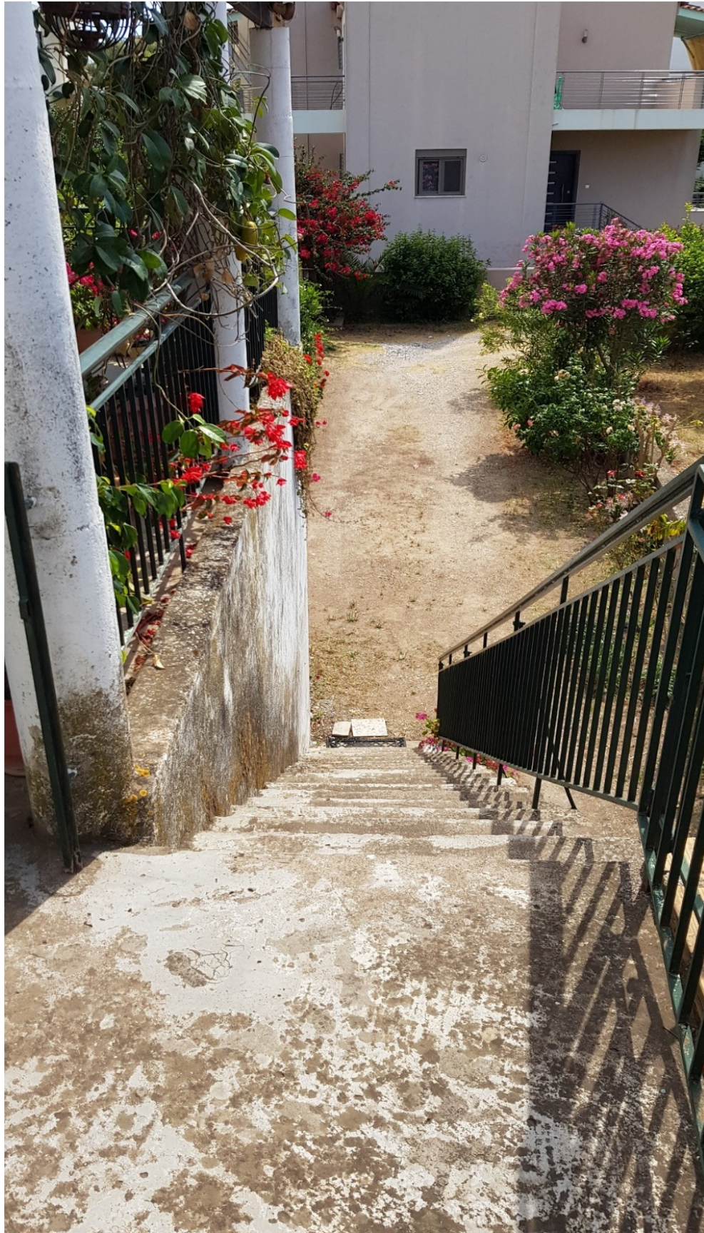
Φωτογραφία 3. { Απεικόνιση σκάλας από οπλισμένο σκυρόδεμα και προστατευτικού κιγκλιδώματος. }
