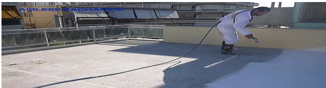
Εικόνα 4.9. [ εφαρμογή μονωτικού υλικού νανοτεχνολογίας σε δόμα. Ανακτήθηκε από : https://www.google.com/search?q=%CE%BC%CE%BF%CE%BD%CF%89%CF%84%CE%B9%CE%BA%CE%B1+%CE%BD%CE%B1%CE%BD%CE%BF%CF%84%CE%B5%CF%87%CE%BD%CE%BF%CE%BB%CE%BF%CE%B3%CE%B9%CE%B1%CF%82&sxsrf=A0aemv1cMbK_VkzBE6TocDmMAw5G_SE09w:1636120574998&source=lnms&tbnm=isch&sa=X&ved=2ahUKewjWnLqNsIH0AhURjqQKHbHdB_AQ_AUoAXoECAEQAw&biw=1920&bih=912&dpr=1#imgre=omD7ficaKMdXwM&imgdii=8DZ7D1fCGd_EJM , στις 16/8/2021.]
