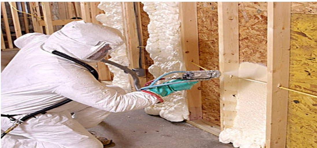
Εικόνα 4.6. [ φωτογραφία που απεικονίζει τον τρόπο εφαρμογής του αφρού πολουρεθανης. Ανακτήθηκε από: http://gr.aonuogroup.com/polyurea/polyurea-raw-materials/polyurethane-foam-for-spraying-interior-wall.html , στις 16/8/2021.]
