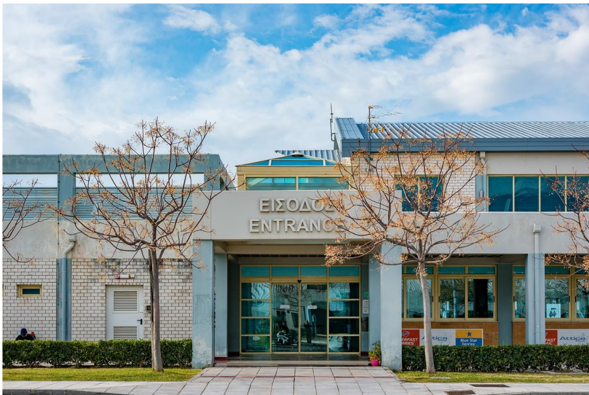
Εικόνα 3.5: Πρώτη είσοδος του κτιρίου υπηρεσιών λιμένα 49
