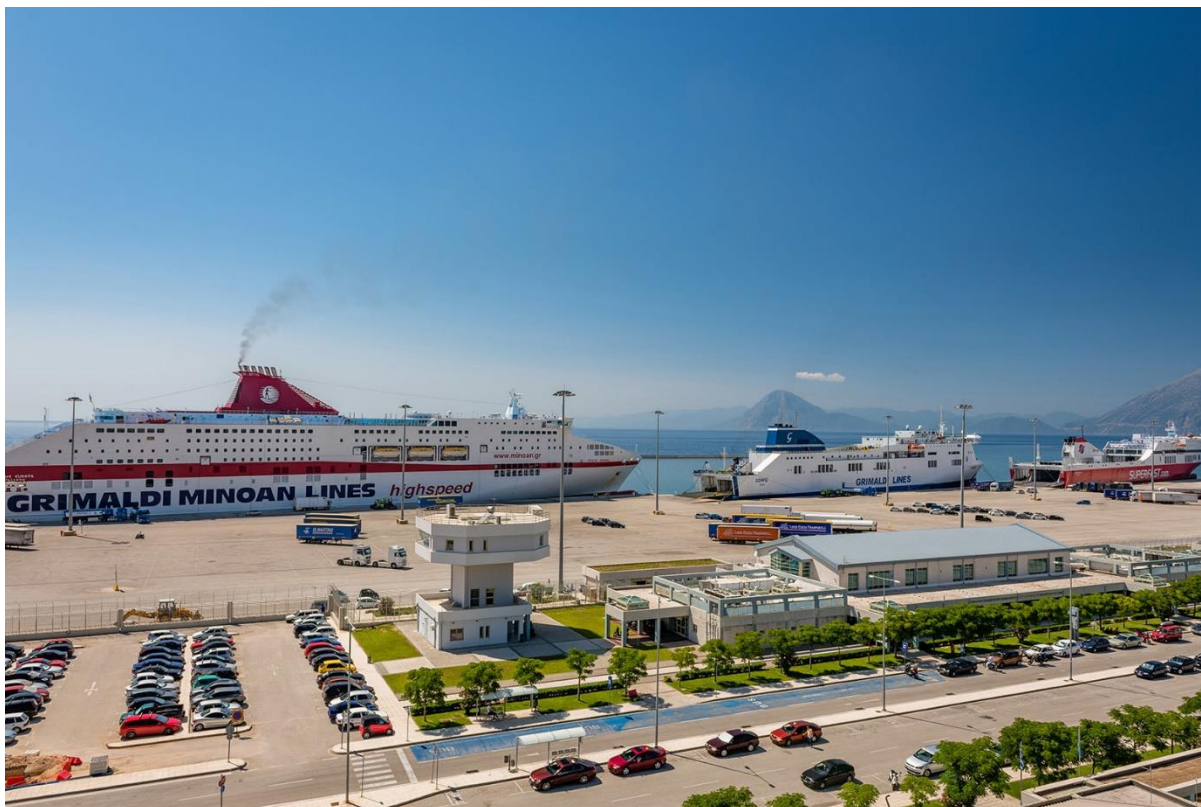
Εικόνα 3.3: Το νέο λιμάνι της Πάτρας, φαίνεται ο τερματικός σταθμός και ο πύργος ελέγχου (ραντάρ) 47
