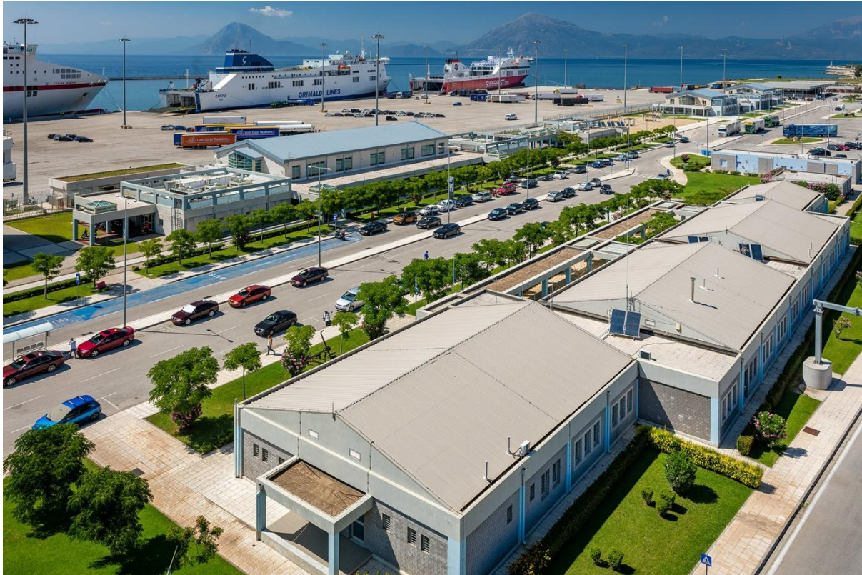
Εικόνα 3.7: Πανοραμική άποψη του κτιρίου υπηρεσιών λιμένα 51
