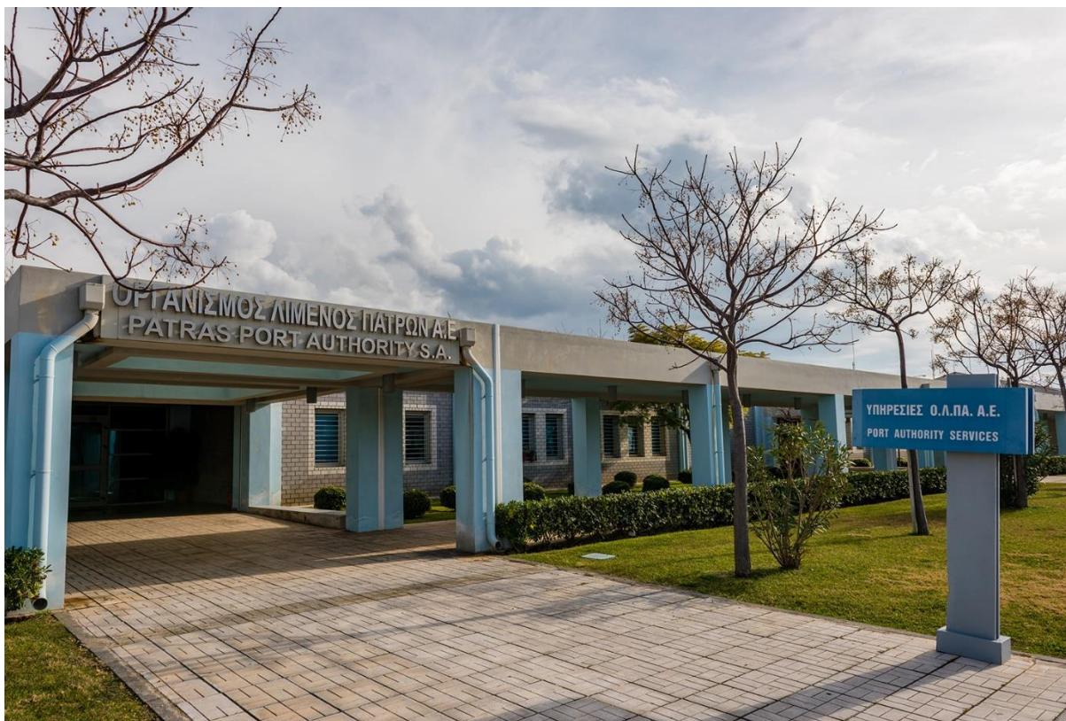
Εικόνα 3.6: Δεύτερη είσοδος του κτιρίου υπηρεσιών λιμένα 50
