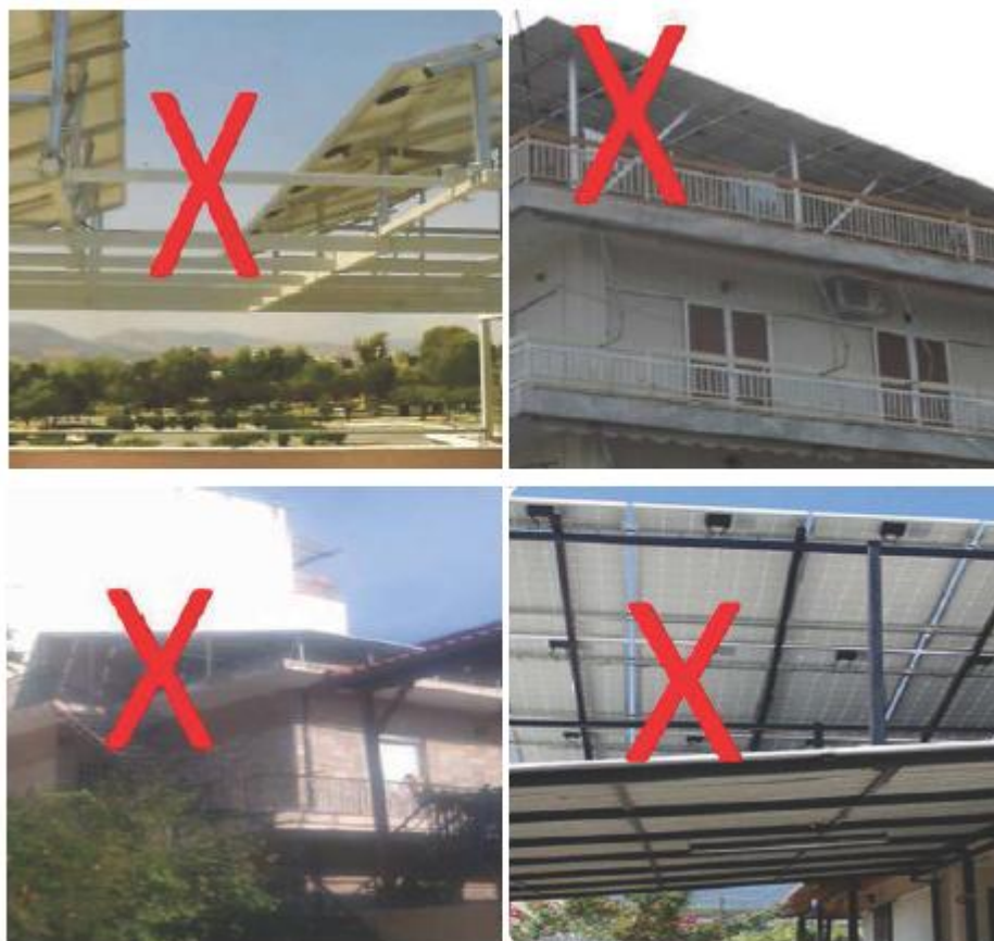
Εικόνα 3-7 Ενδεικτικά παραδείγματα μη επιτρεπτής τοποθέτησης σε δώματα
