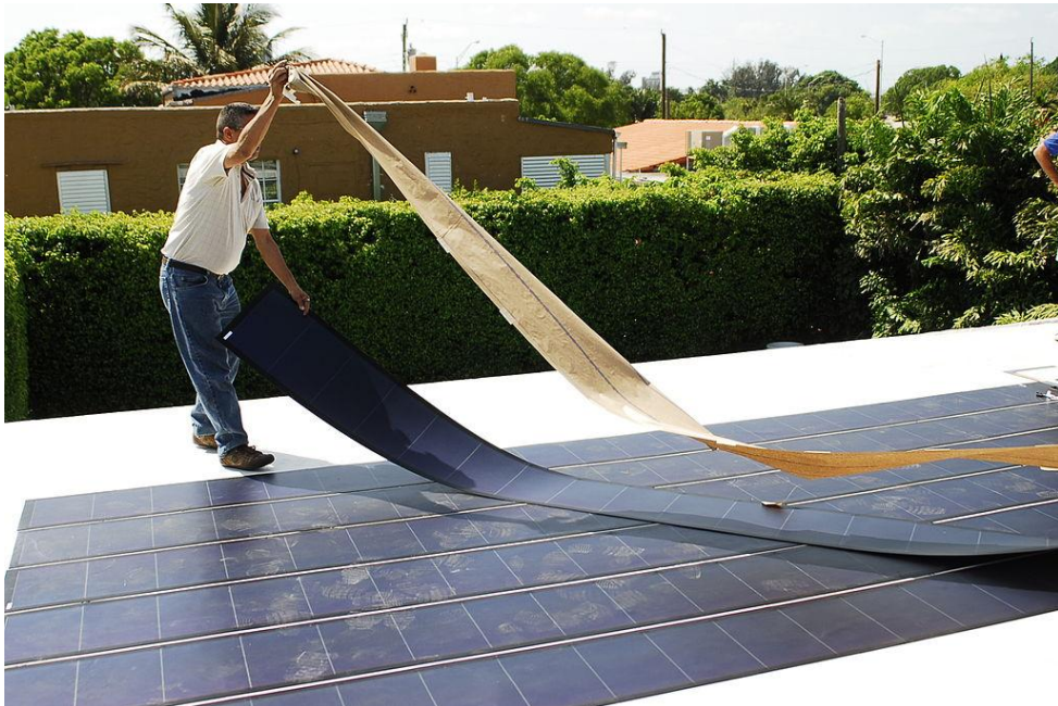
Εικόνα 4-3 Φ/Β στοιχεί ταινίας άμορφου πυριτίου
