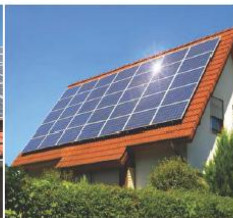
Εικόνα 3-3 Ενδεικτικά παραδείγματα επιτρεπτής τοποθέτησης σε στέγες
