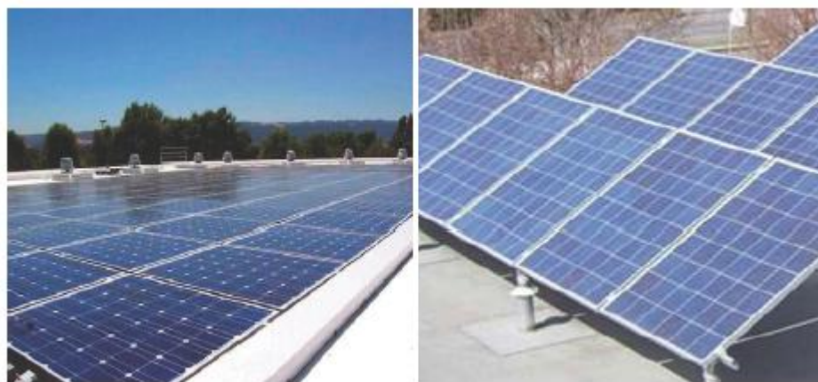
Εικόνα 3-6 Ενδεικτικά παραδείγματα επιτρεπτής τοποθέτησης σε δώματα
