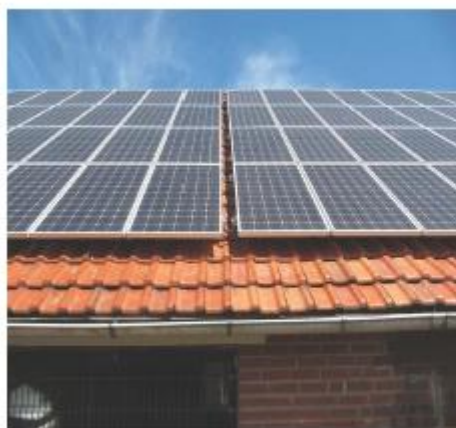
Εικόνα 3-3 Ενδεικτικά παραδείγματα επιτρεπτής τοποθέτησης σε στέγες
