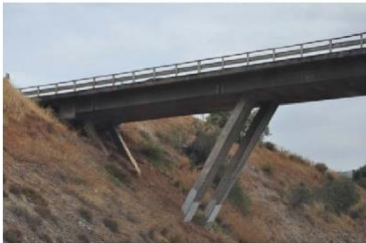
Σχήμα 3- 3 Άποψη μεσοβάθρου Μ1 Άνω Διάβασης Α296.
