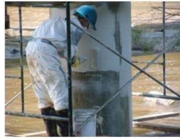
Εικόνα 2- 8: Στο ίδιο υποστήλωμα τοποθετείται γκρι χρωματισμός για να ταιριάζει με το σκυρόδεμα του υποστυλώματος.
