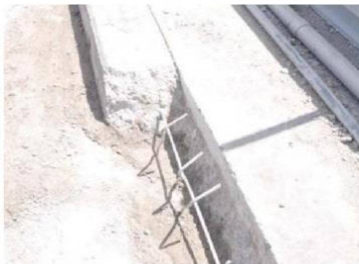
Σχήμα 3- 15 Καθαίρεση τμήματος του υφιστάμενου πεζοδρομίου για ενσωμάτωση σε αυτό καναλιού συλλογής όμβριων.
