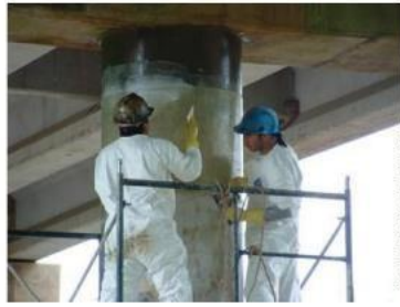
Εικόνα 2- 4: Εργάτες τοποθετούν δύο τμήματα περικάλυμτος ινοπλισμένου πολυμερούς σε ένα υποστήλωμα.
