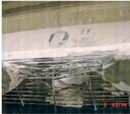
Εικόνα 2- 11(α, β, γ): Κατάστρωμα γέφυρας σε ανισόπεδη διάβαση. Ζημιά από όχημα με ύψος πέραν του επιτρεπόμενου και επισκευή με σύνθετα υλικά.
