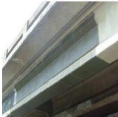
Εικόνα 2- 11(α, β, γ): Κατάστρωμα γέφυρας σε ανισόπεδη διάβαση. Ζημιά από όχημα με ύψος πέραν του επιτρεπόμενου και επισκευή με σύνθετα υλικά.
