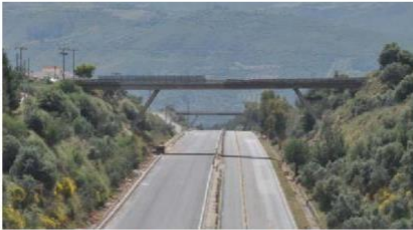
Σχήμα 3- 2 Γενική άποψη της Άνω Διάβασης Α296.
