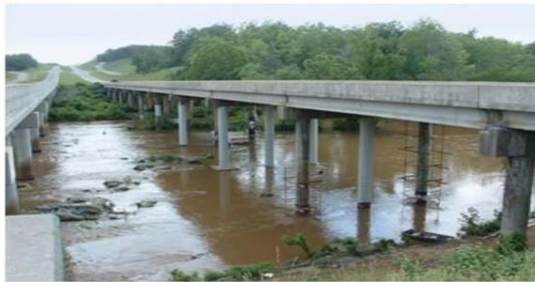
Εικόνα 2- 9: Αυτή η όψη της γέφυρας (Chatham County bridge) είναι στα τελικά στάδια περικάλυψης με ινοπλισμένα πολυμερή και τα στάδια του βαψίματος. Η ολοκληρωμένη εργασία διακρίνεται από το ανοιχτό γκρι χρώμα.
