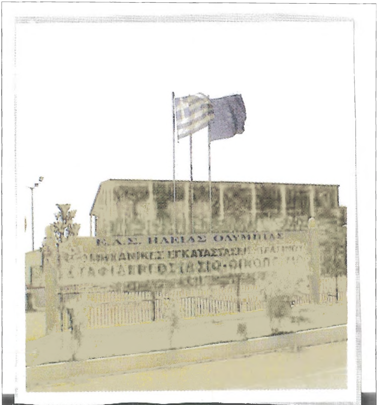
Το Σταφιδεργαστάσιο- Οινοποιείο της Ε.Α.Σ στο 7 χλμ της Εθνικής οδού Πύργου – Πατρών.
