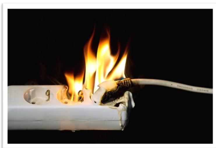
Εικόνα 3.1 : Λιώσιμο αγωγού προερχόμενο από βραχυκύκλωμα. [54]
