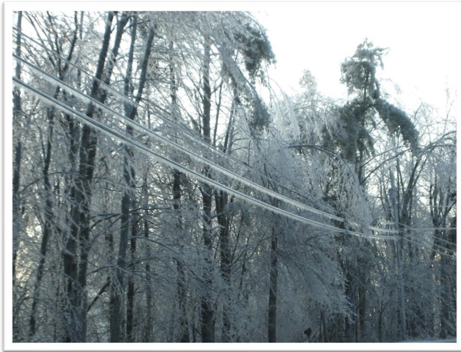
Εικόνα 4.2 : Γραμμές μεταφοράς «ντυμένες» με στρώμα πάγου. [40]
