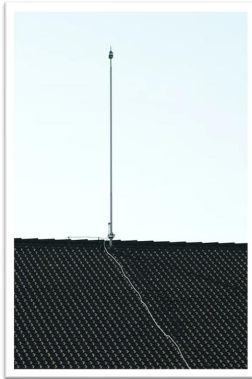
Εικόνα 7.1 : Αλεξικέραυνο τοποθετημένο στην σκεπή ενός κτηρίου. [1]
