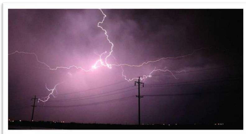
Εικόνα 2.9 : Κεραυνός πλήττει εναέρια γραμμή μεταφοράς. [54]
