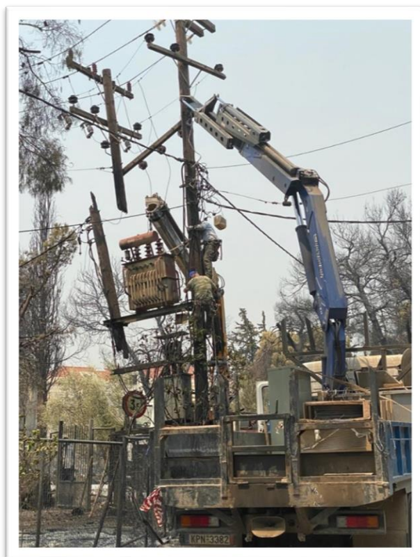
Εικόνα 4.4 : Αποκατάσταση καμένων μετασχηματιστών στη Βαρυμπόμπη. [48]
