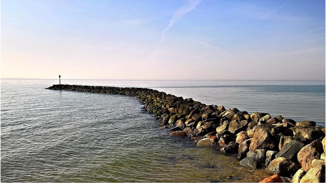
Εικ.4.2.2 Έξαλλος κυματοθραύστης
