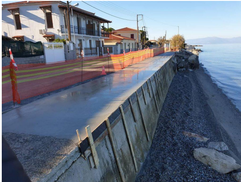
Εικ.4.2.6 Τοίχος αντιστήριξης
