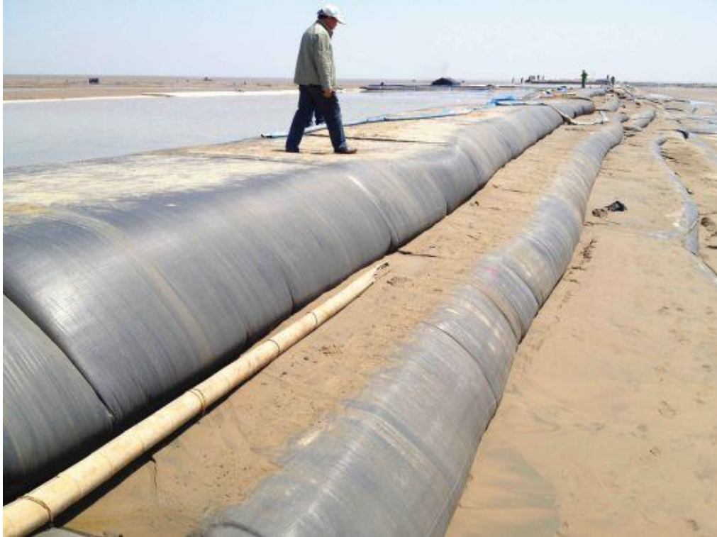
Εικ.4.3.12 Χρήση γεωσωλήνων για την πρόληψη κατά της διάβρωσης
