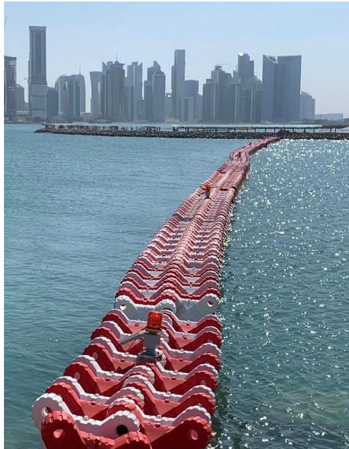
Εικ.4.3.2 Κατασκευή πλωτού κυματοθραύστη
