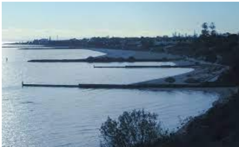
Εικ.4.2.4 Πρόβολοι ή βραχίονες κάθετοι στην ακτογραμμή
