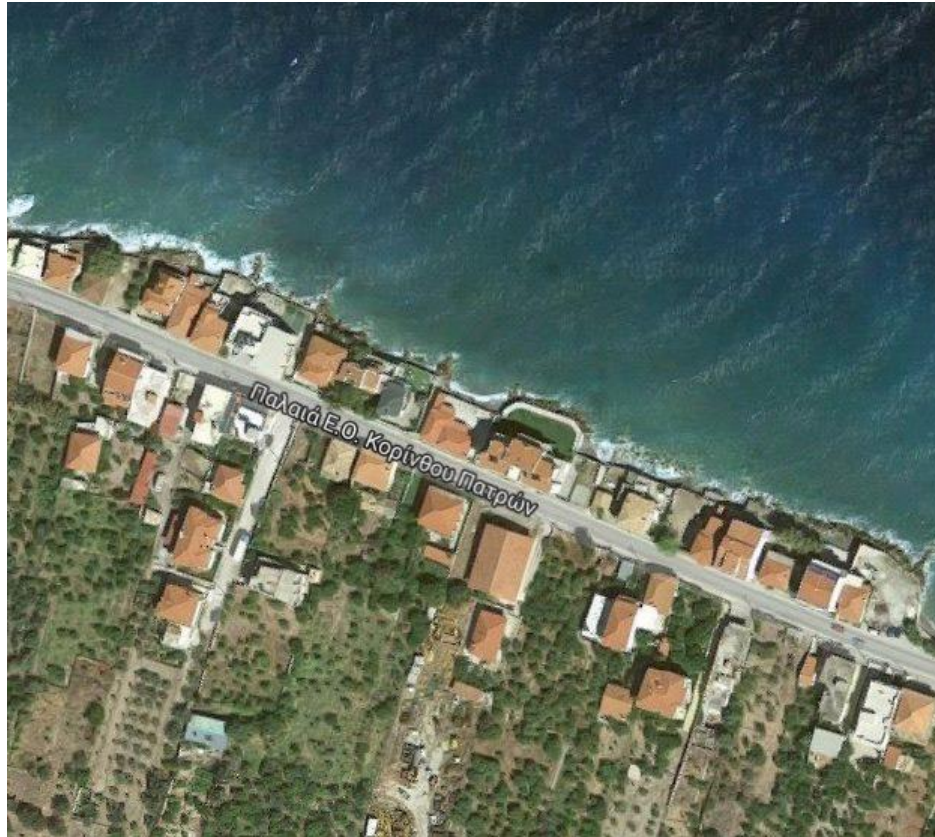
Εικ.3.2.2 Κατασκευές στο ενεργό μέτωπο της ακτογραμμής
