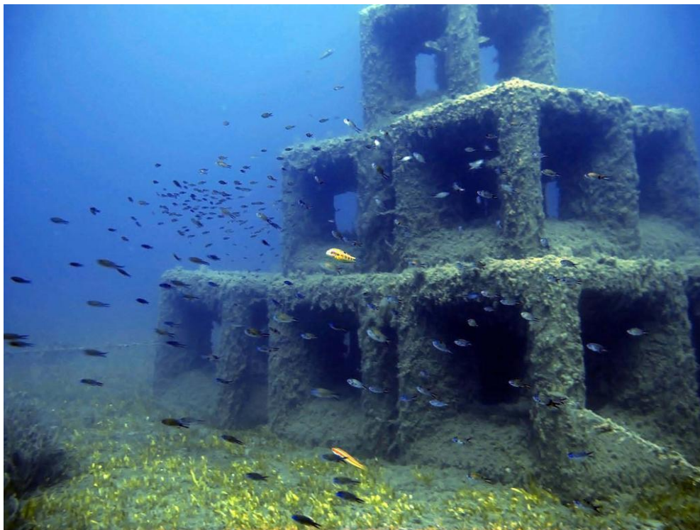
Εικ.4.2.3 Ύφαλος κυματοθραύστης
