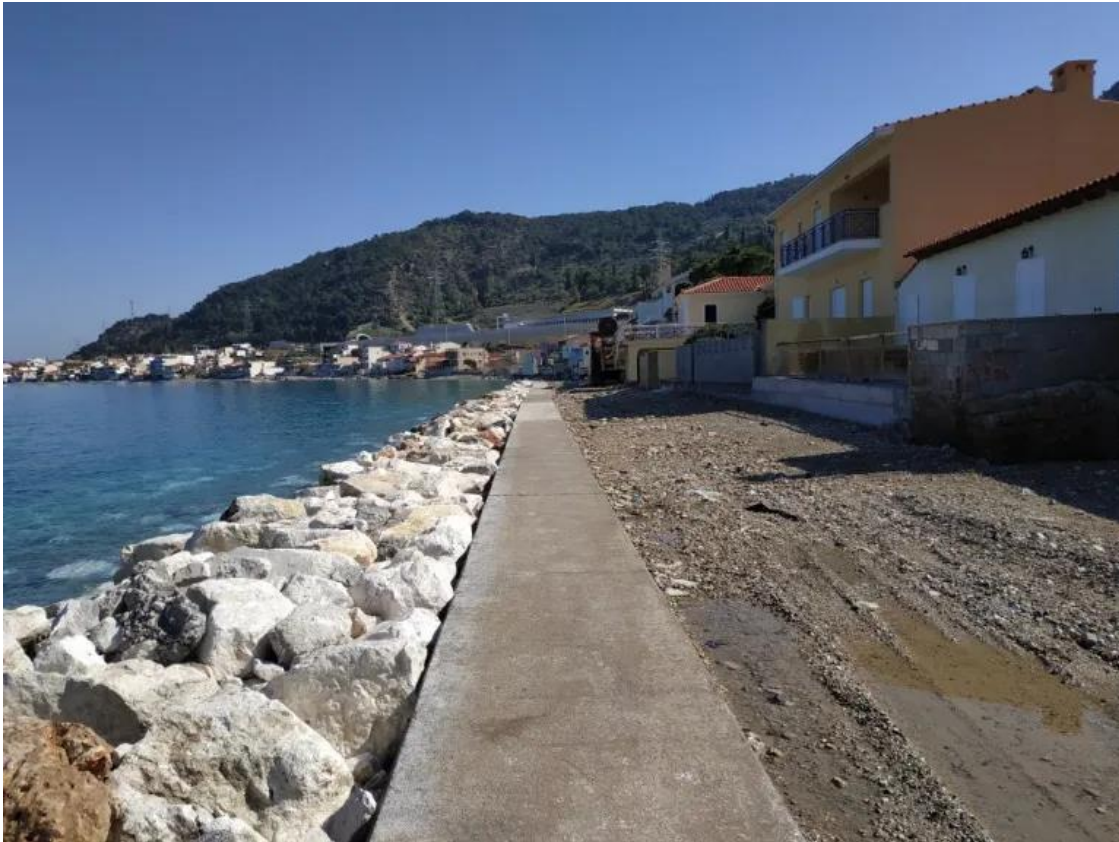
Εικ.4.2.5 Κατασκευή λιθοριπής και τοίχους αντιστήριξης
