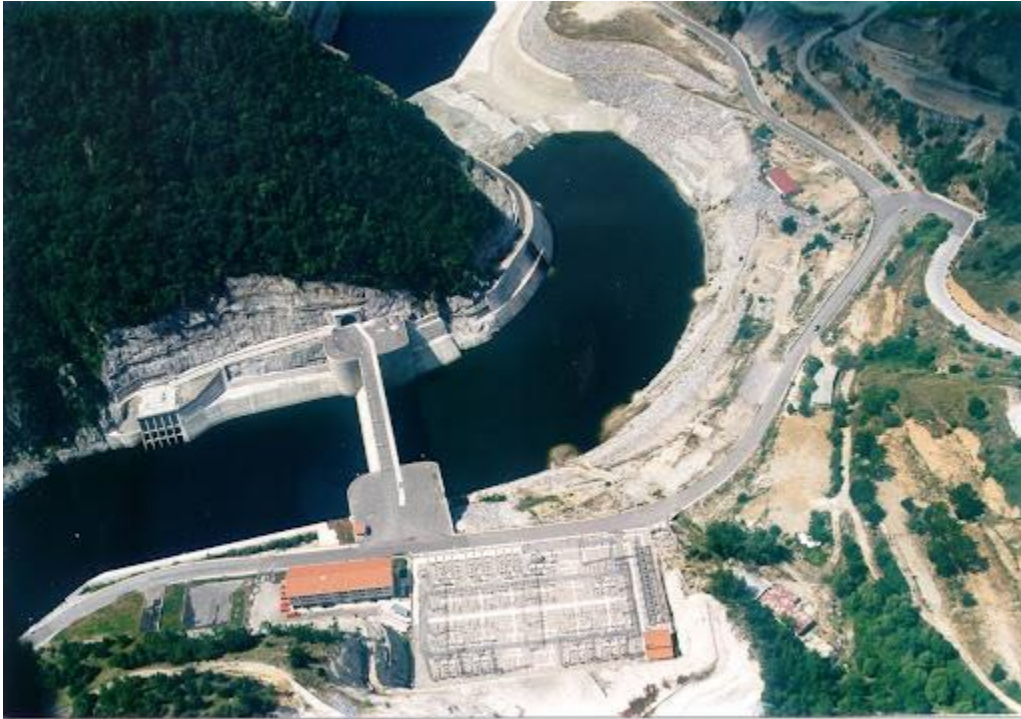
Εικ.3.2.6 Φράγμα, αιτία διάβρωσης
