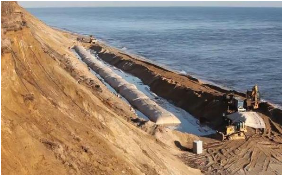
Εικ.4.3.10 Προστασία βάσης κρημνού με χρήση γεω-υφασμάτων
