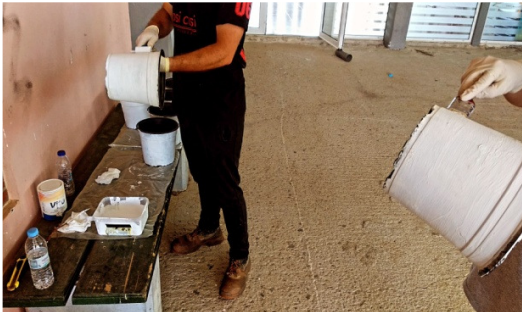
Εικόνα 16: Βάψιμο γλαστρών σε άσπρο χρώμα
