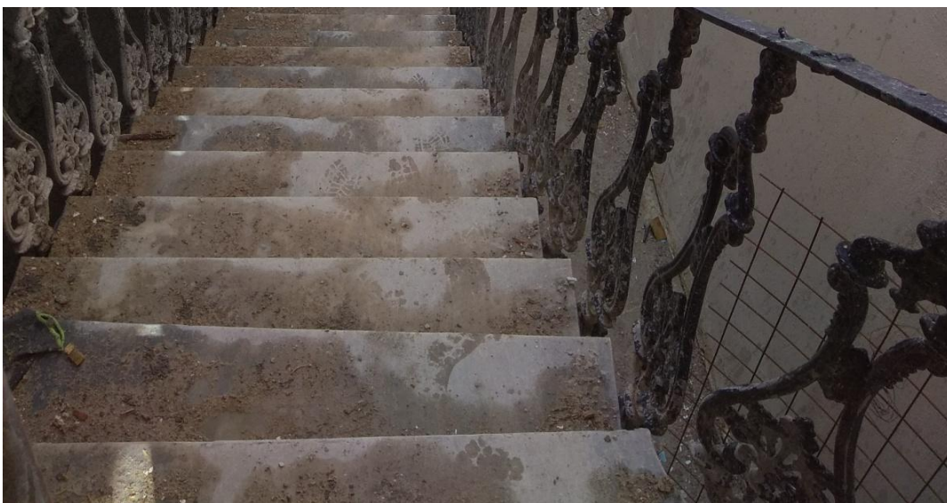
Εικόνα 25. Κιγκλιδώματα κλίμακας
