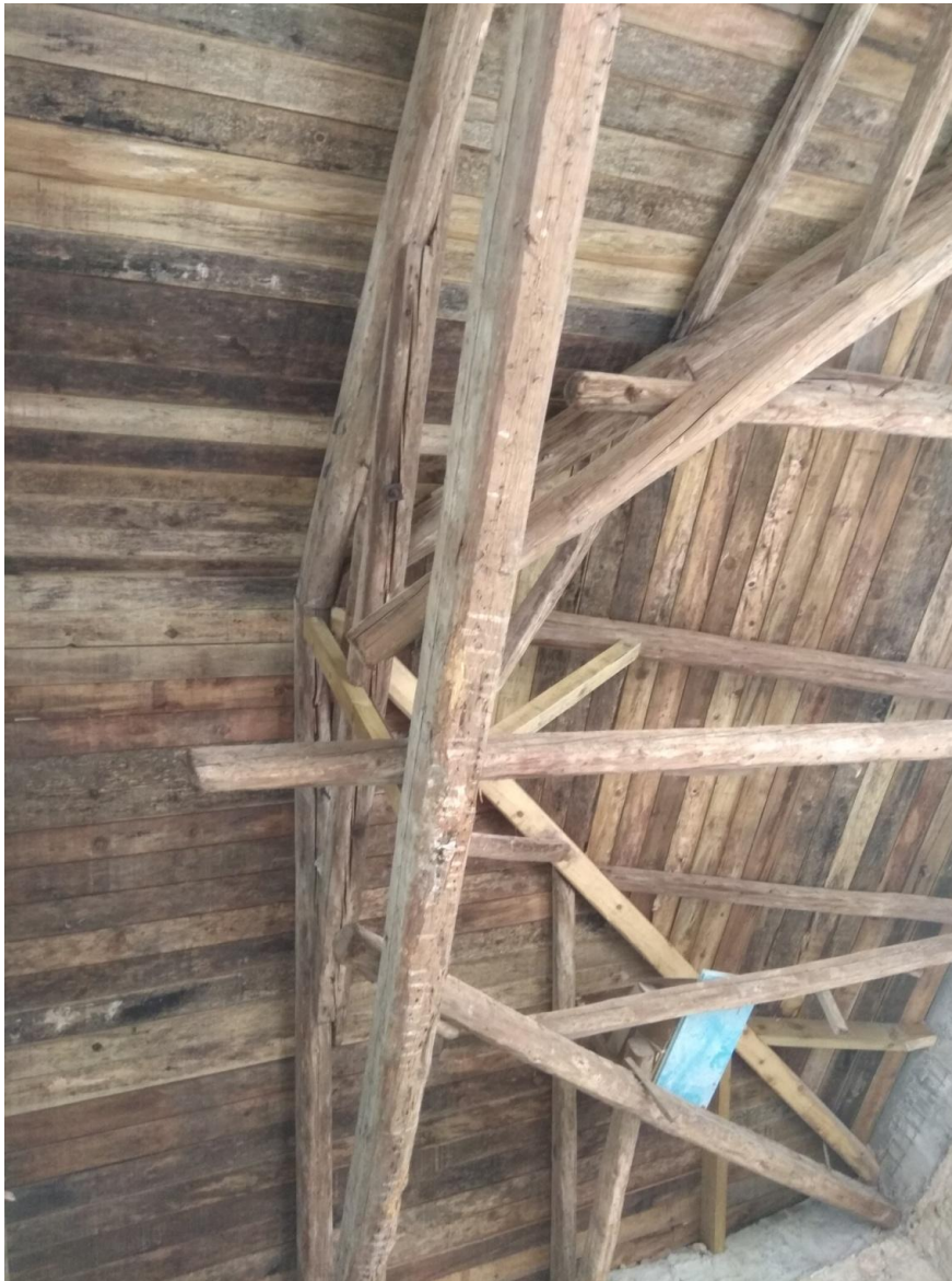
Εικόνα 34. Λεπτομέρεια ξύλινου φορέα νέας στέγης
