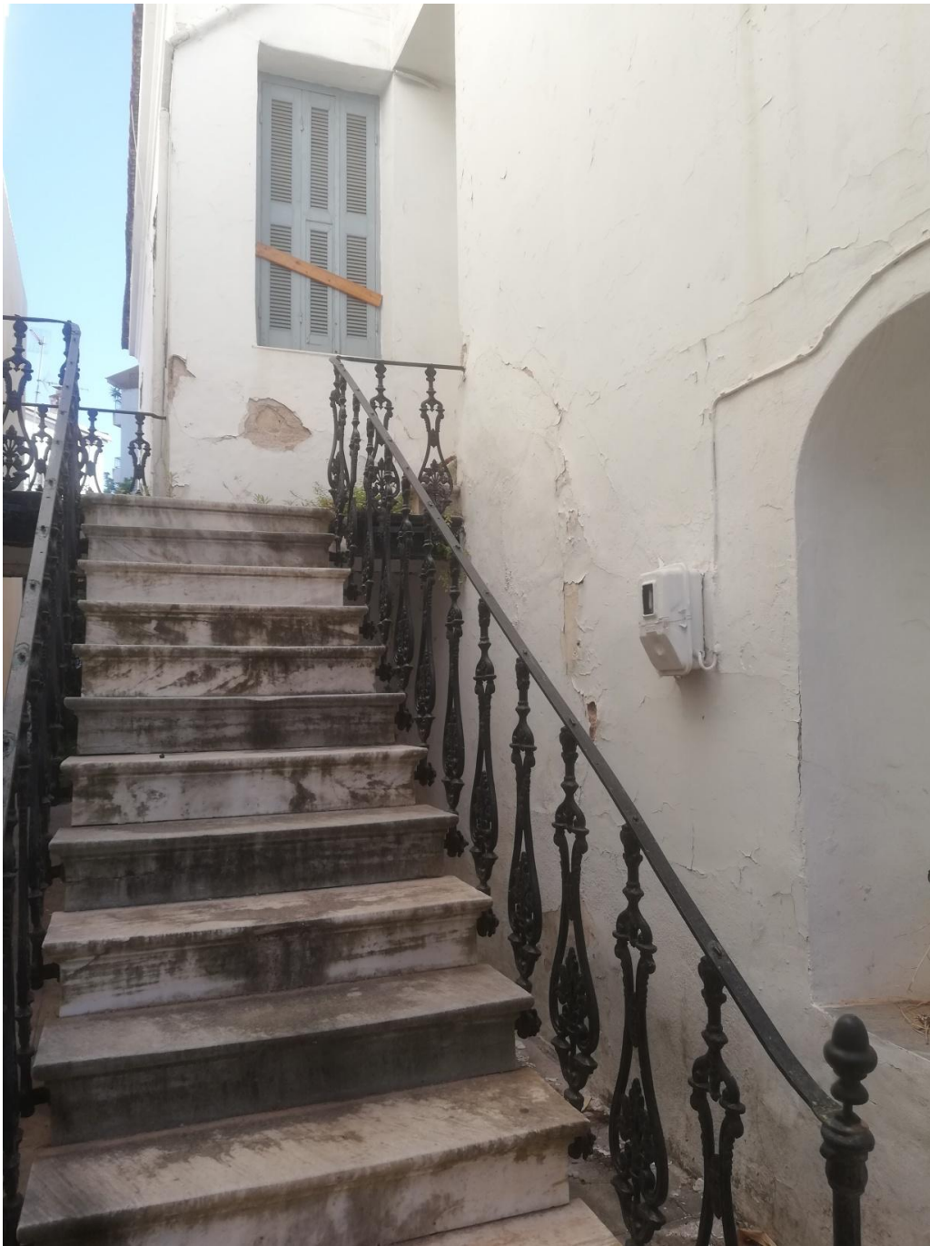
Εικόνα 17. Παλαιότερη φωτογραφία του κτηρίου (πριν επιλεγθεί ως θέμα πτυχιακής)
