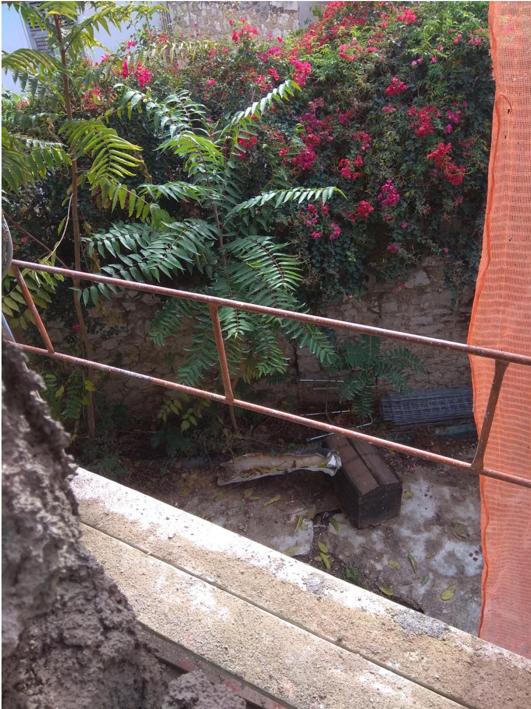
Εικόνα 30. Μέρος της εξωτερικής αυλής και της περίφραξης
