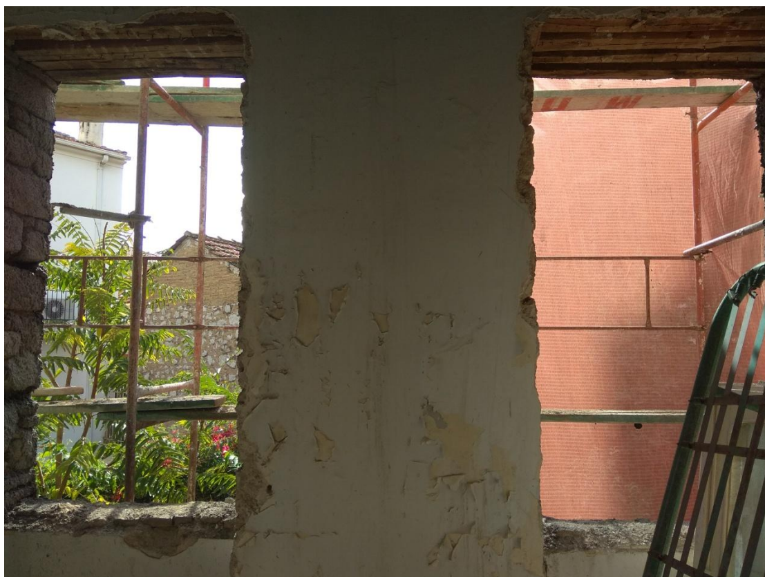
Εικόνα 35. Εικόνα του επιχρίσματος εσωτερικά του κτηρίου στο επίπεδο του ορόφου
