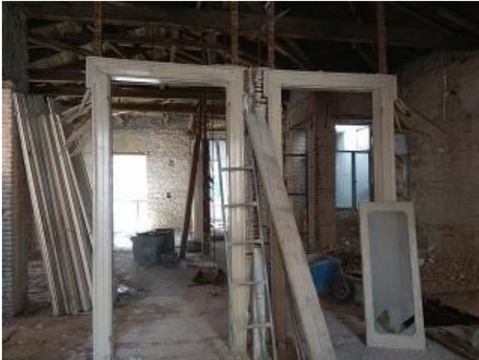
Εικόνα 42. Κουφώματα εσωτερικών θυρών ορόφου και μέρος φύλλο παραθύρου
