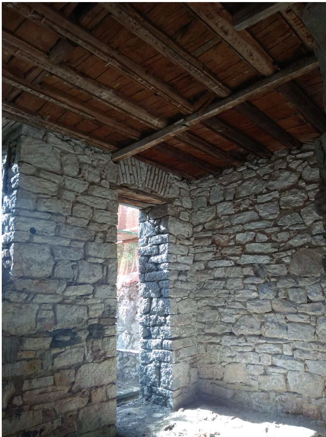
Εικόνα 40. Ξύλινος φορέας πατώματος οροφής
