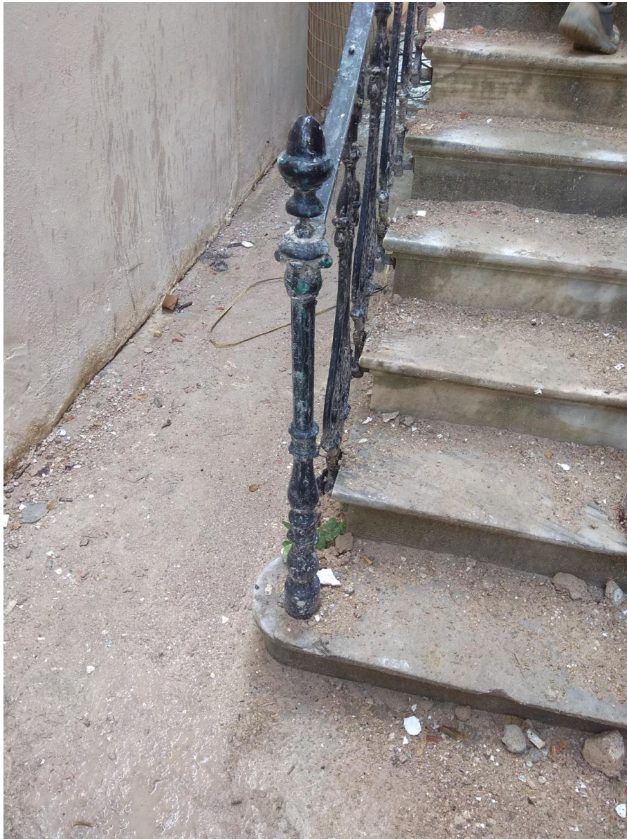
Εικόνα 44. Τμήμα της μαρμάρινης εξωτερικής σκάλας
