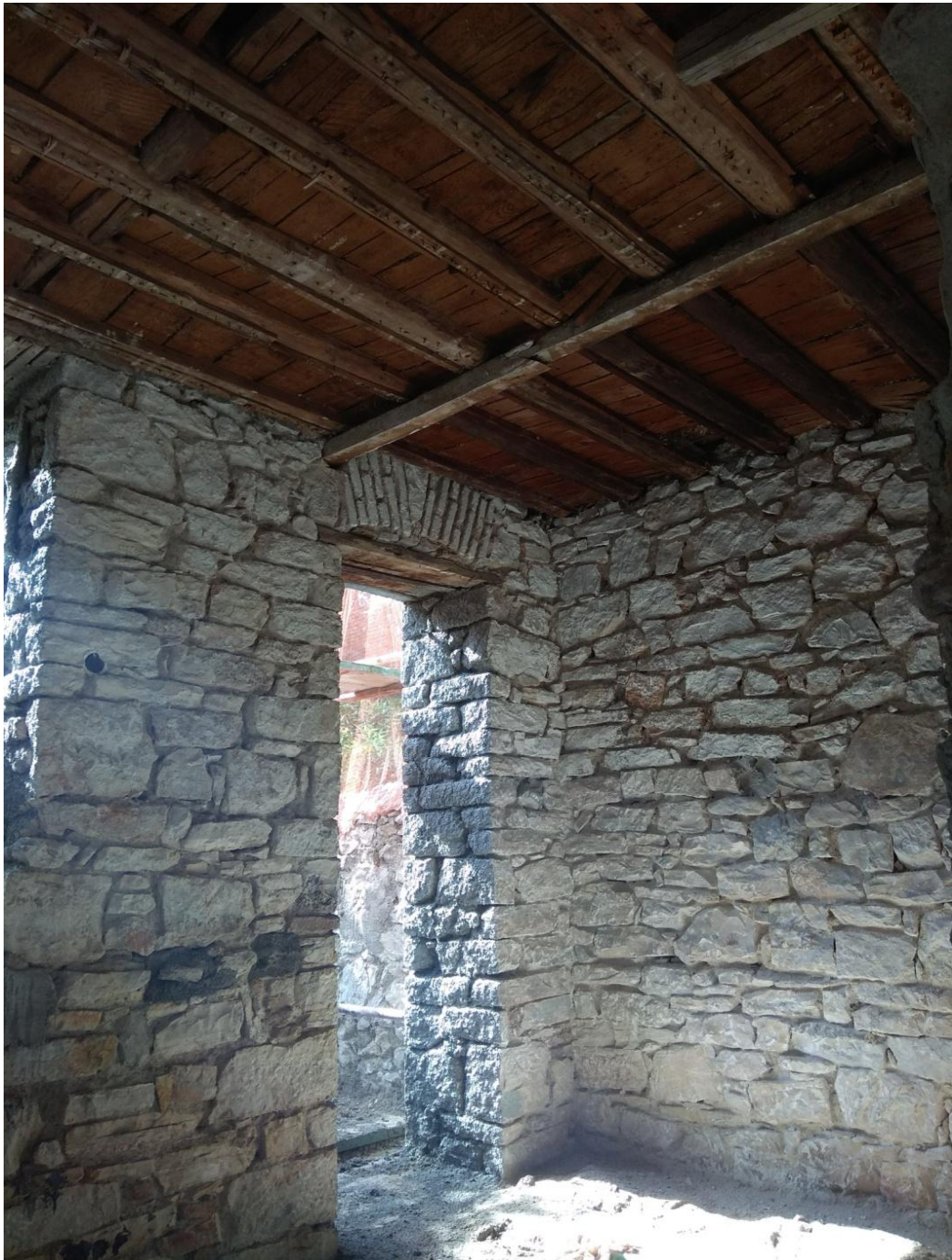
Εικόνα 18. Ξύλινο μεσοπάτωμα στηριζόμενο από ξύλινο φορέα
