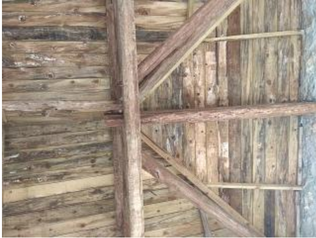
Εικόνα 11. Ξύλινος φορέας στέγης
