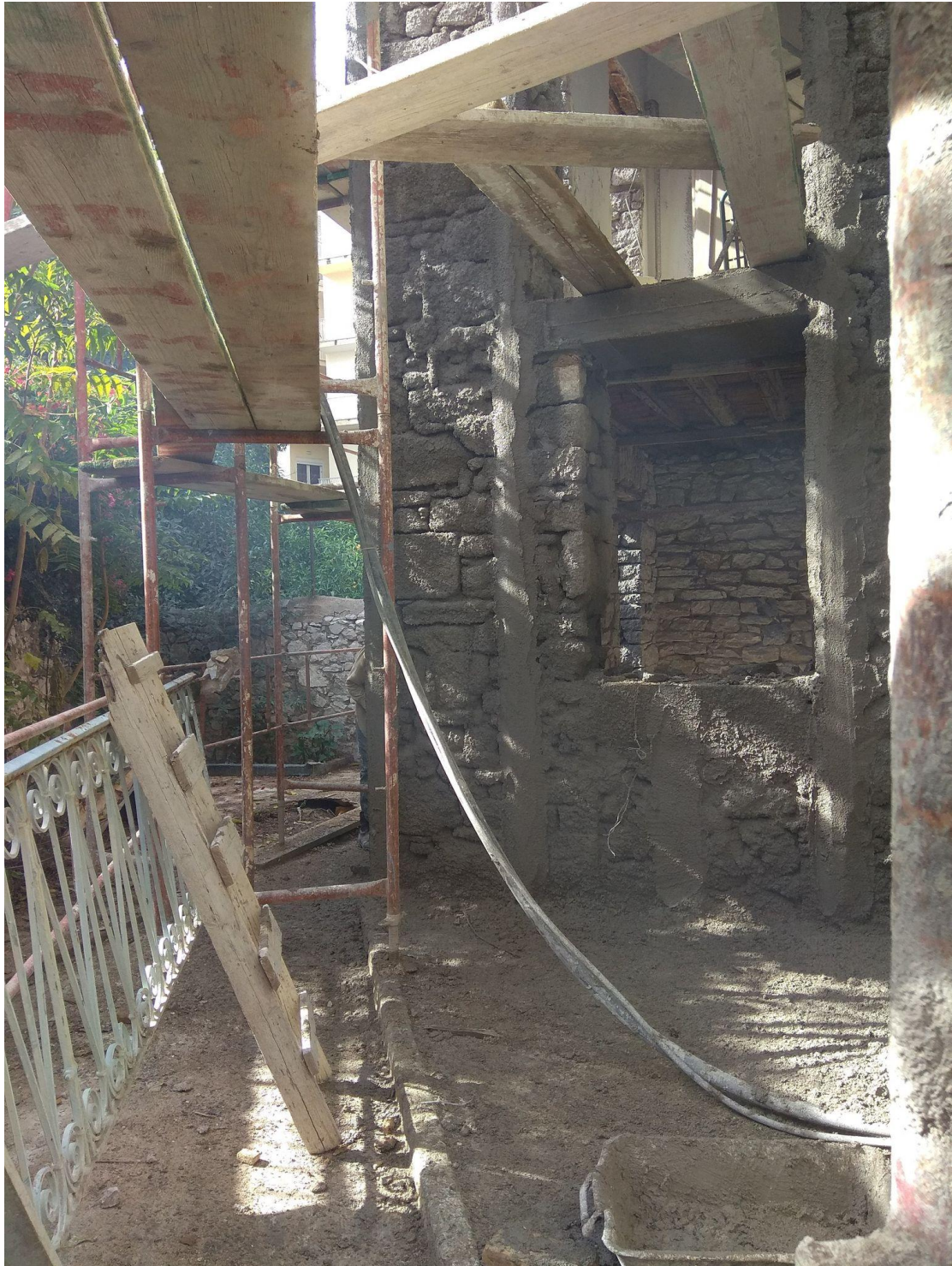
Εικόνα 31. Μέρος της εξωτερικής αυλής και της περίφραξης
