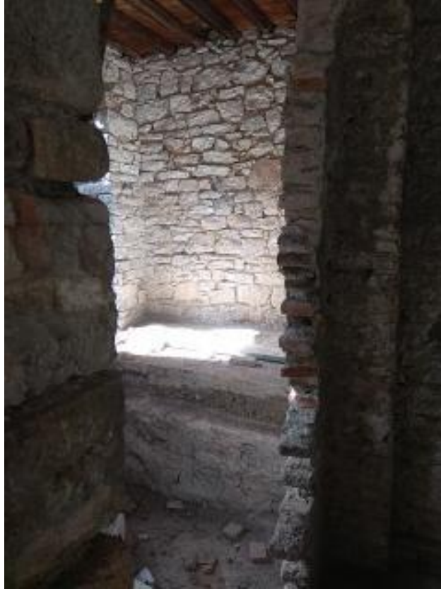
Εικόνα 13. Λεπτομέρεια λιθοδομής και οπτοπλινθοδομής
