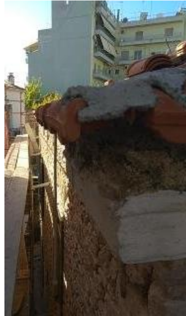
Εικόνα 12. Επίστεψη με κεραμοσκεπή
