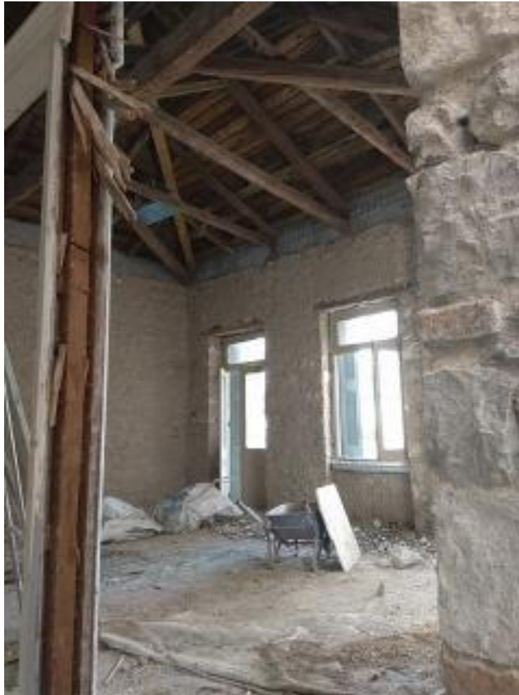
Εικόνα 41. Ξύλινο πάτωμα ορόφου
