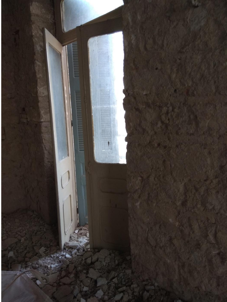
Εικόνα 19. Τυπική ταμπλαδωτή εξώθυρα με γαλλικά εξώφυλλα
