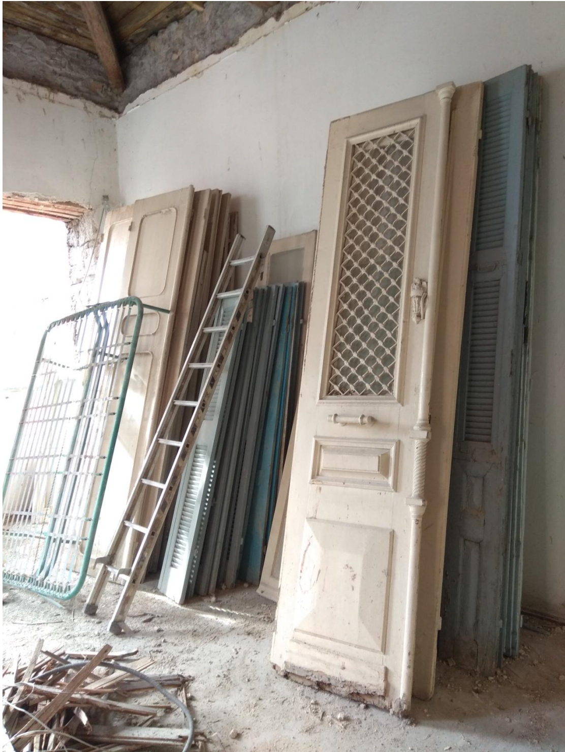
Εικόνα 20. Ταμπλαδοτή εξώθυρα ορόφου, γαλλικά εξώφυλλα και αναδιπλούμενες θύρες
