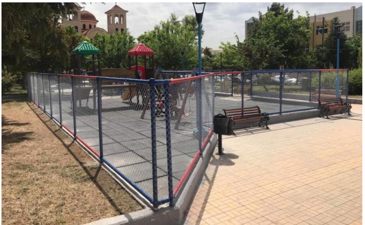
Εικόνα 10: Περίφραξη με πλέγμα και Σωλήνα
