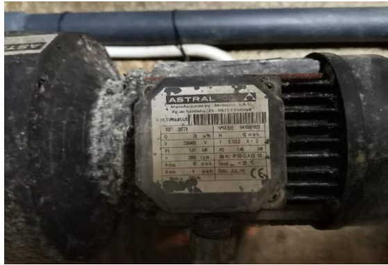
Εικόνα 2.20: Αντλία κυκλοφορίας νερού πισίνας Bombas(1.5Kw, Q=27m 3 /h
