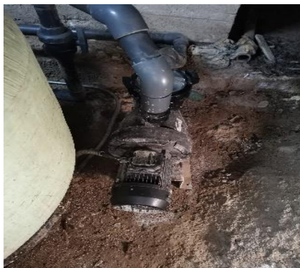
Εικόνα 2.19: Αντλία κυκλοφορίας νερού πισίνας Astral(2x1.91 Kw,Q=26m 3 /h)
