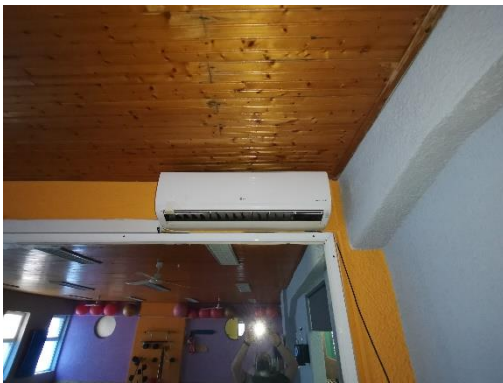
Εικόνα 2.11: Κλιματιστικό LG E24SQ-24,000 BTU/h
