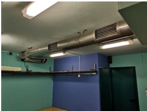
Εικόνα 2.17: Αεραγωγός λουτήρων (2x0.25kW)
