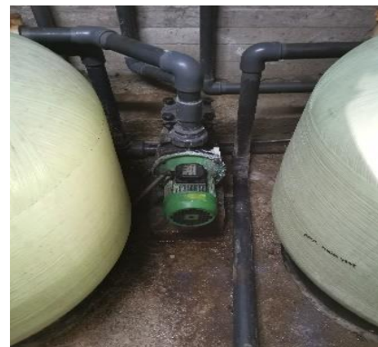
Εικόνα 2.19: Αντλία κυκλοφορίας νερού πισίνας Astral(2x1.91 Kw,Q=26m 3 /h)
