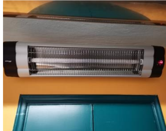
Εικόνα 2.16: Θερμοπομπός λουτήρων Mistral-2x2.5kW
