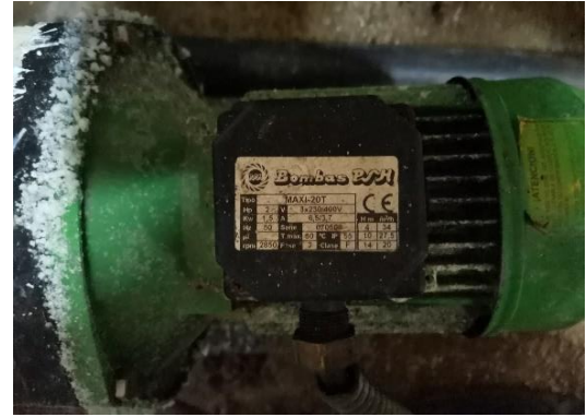
Εικόνα 2.20: Αντλία κυκλοφορίας νερού πισίνας Bombas(1.5Kw, Q=27m 3 /h
