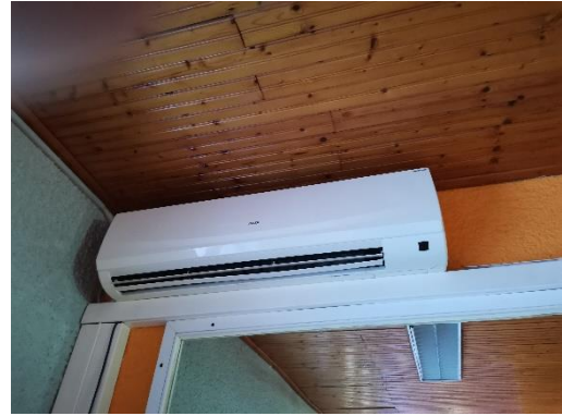
Εικόνα 2.10: Κλιματιστικό AUX 24,000 BTU/h
