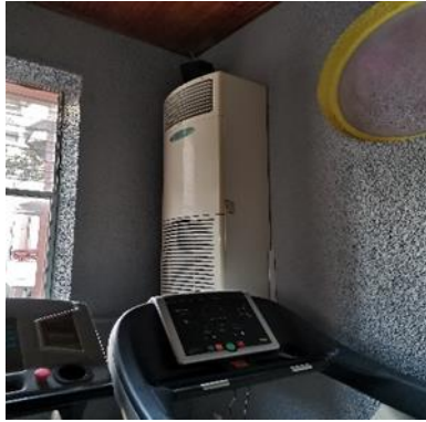
Εικόνα 2.9: Κλιματιστικό TOYOTOMI-FST1460-66,000 BTU/h
