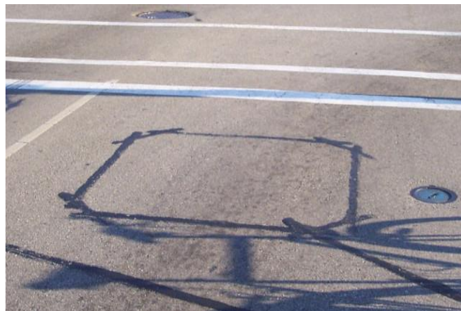
Εικόνα 44: Παράδειγμα ανιχνευτή οχήματος επαγωγικού βρόχου.
