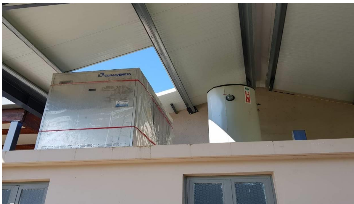
Εικόνα 3-11: Το ψυκτικό (αριστερά) και η δεξαμενή του (δεξιά)
