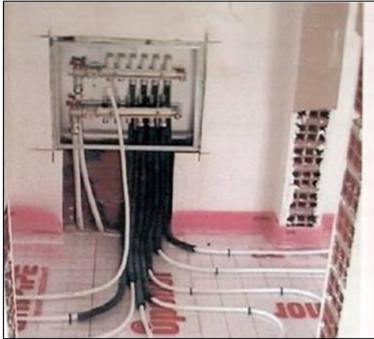
Εικόνα 1.4: Συλλέκτες Διανομής Με Μόνωση
