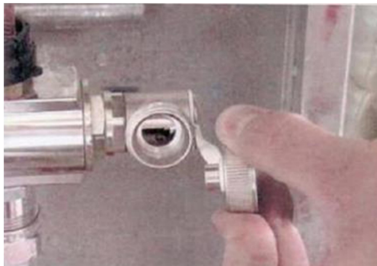
Εικόνα 1.5: Αυτόματος Εξαερωτής
