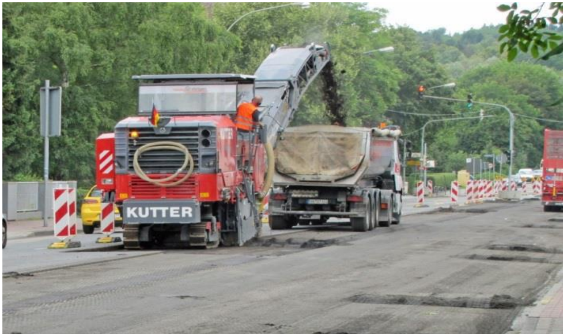
Εικόνα 26: Ήλωση οδοστρώματος (KUTTER, 2014)
