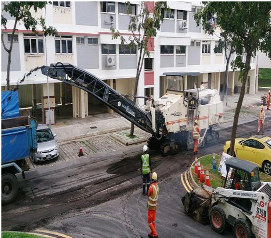
Εικόνα 27: Χάραξη – εκτομή οδοστρώματος (Milling) (Lightbreather, 2014)
