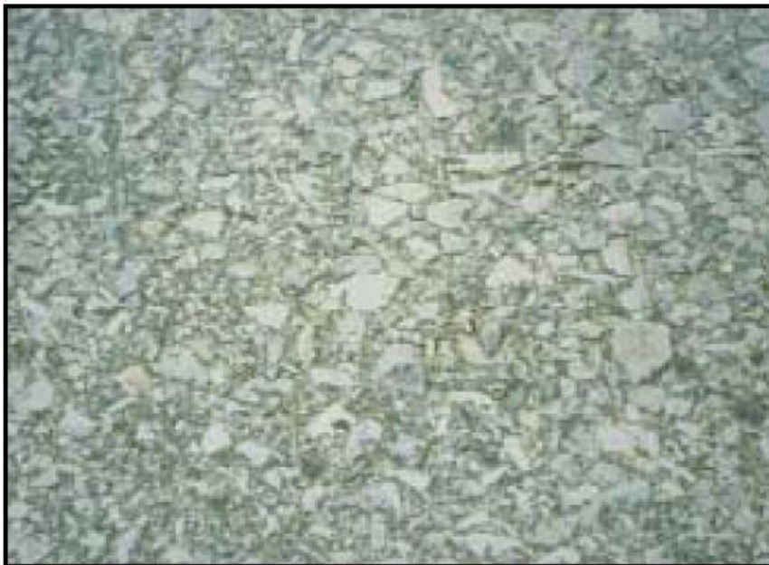
Εικόνα 25: Λείανση αδρανών σε οδόστρωμα [10]
