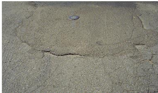
Εικόνα 19: Μέσης σοβαρότητας μπαλώματα[10]
