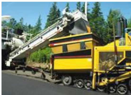
Εικόνα 29: Απόξεση οδοστρώματος (Planing) [8]
