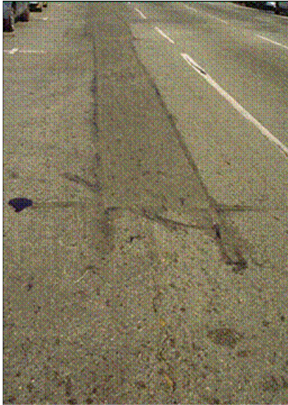
Εικόνα 21: Χαμηλής σοβαρότητας μπαλώματα [10]
