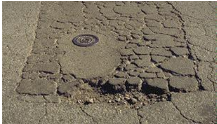
Εικόνα 20: Υψηλής σοβαρότητας μπαλώματα [10]
