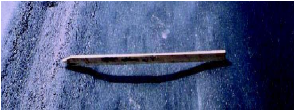
Εικόνα 17: Αυλακώσεις στις τροχιές των τροχών [10]
