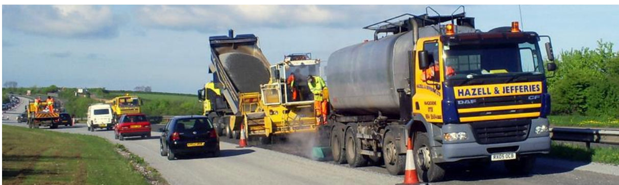
Εικόνα 31: Διάστρωση ασφαλτικής επίστρωσης (Surface dressing, n.d.)
