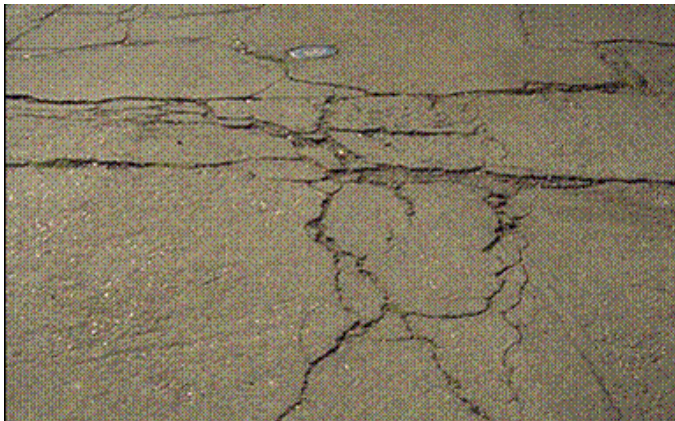
Εικόνα 16: Υψηλής έντασης ρωγμές συρρίκνωσης [10]
