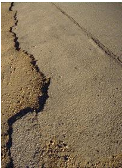
Εικόνα 22: Μορφές σοβαρότητας αποκόλλησης αδρανών (α, β, γ) [10]
