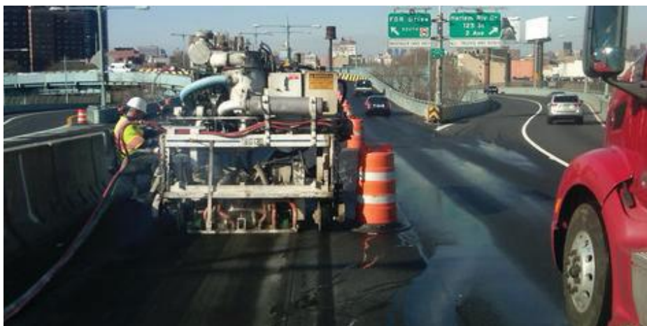
Εικόνα 28: Χάραξη – πριονισμός οδοστρώματος (Grooving) [4]
