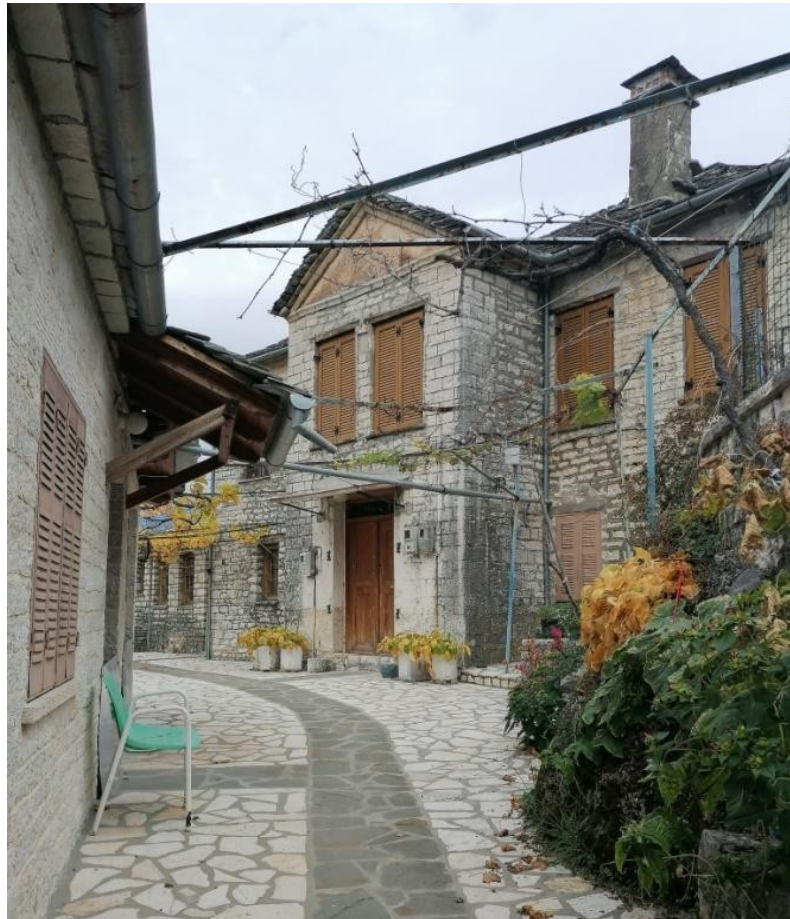
Σπίτι με αέτωμα στη στέγη(1870)
