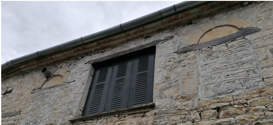
Παράθυρο με ξύλινο πρέκι και ανακουφιστικό πέτρινο τόξο
