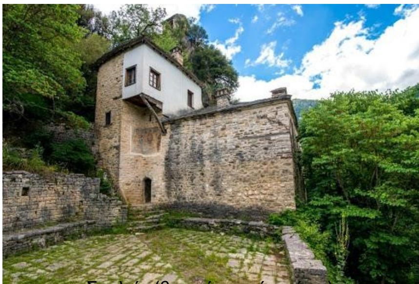
Σχολείο (βορινή και νότια όψη)
