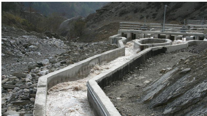
Εικόνα 9: Σήραγγα προσαγωγής [Πηγή: Χασιακός και Φαρμάκης, 2019]
