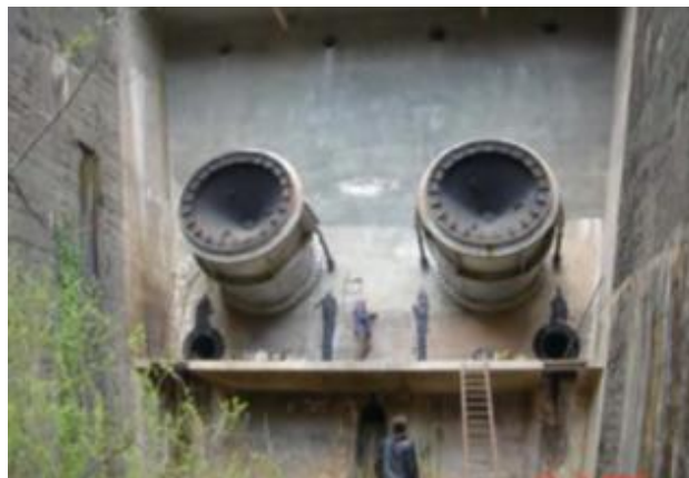
Εικόνα 7: Εκκενωτής Πυθμένα [Πηγή: Χασιακός και Φαρμάκης, 2019]
