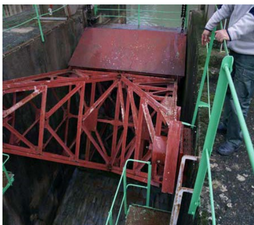
Εικόνα 6.5.1: Τοξωτό Θυρόφραγμα
