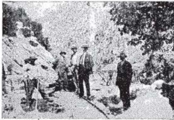
Εικόνα 6.1: Εργασίες κατασκευής ΜΥΗΣ Γλαύκου
