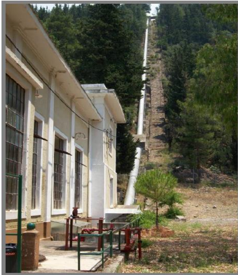
Εικόνα 6.9: Αγωγός πτώσης ΜΥΗΣ Γλαύκου
