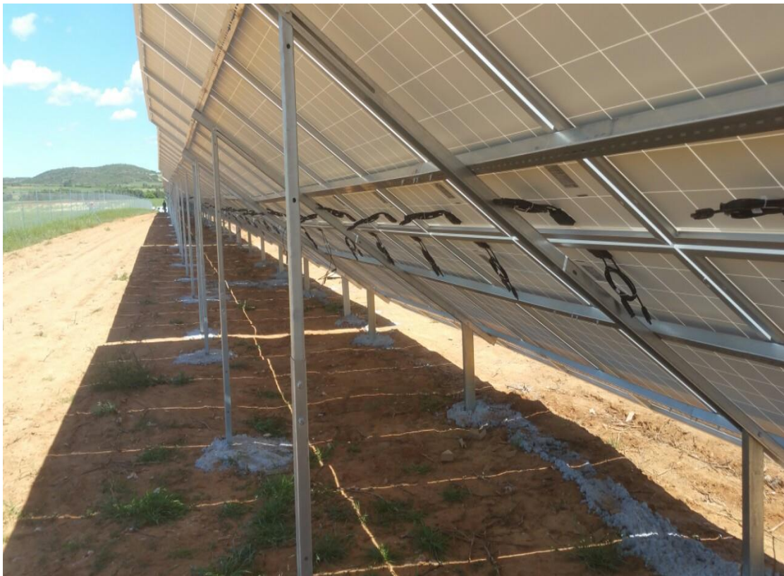
Εικόνα 43: Βάσεις στήριξης των φωτοβολταϊκών πλαισίων με τη μέθοδο της εδαφόμπτυξης
