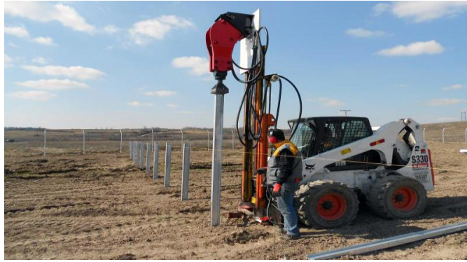
Εικόνα 28: Μέθοδος της πασσαλόμπτυξης
