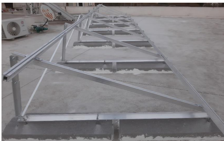
Εικόνα 27: Μέθοδος της σκυροδέτησης
