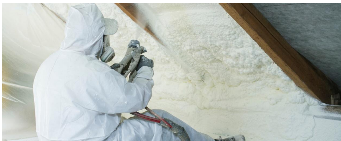
Εικόνα 2.9.2 Εφαρμογή πολυουρεθάνης
