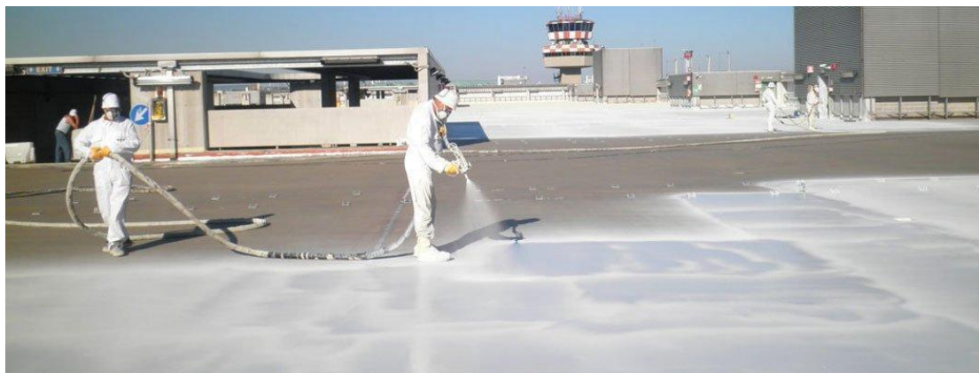
Εικόνα 2.9.3 Εφαρμογή Πολυουρίας
