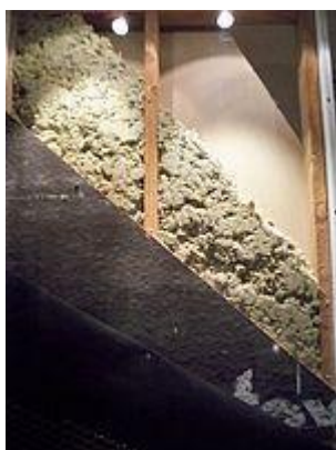
Εικόνα 2.3.1 Διατομή μόνωσης σπιτιού.
