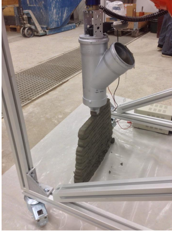
Εικόνα 4.23 Πλάγια όψη του τοιχίου.
