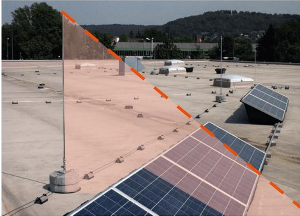
Εικόνα 5-2 Προσδιορισμός του προστατευμένου όγκου με χρήση του προστατευτικού
