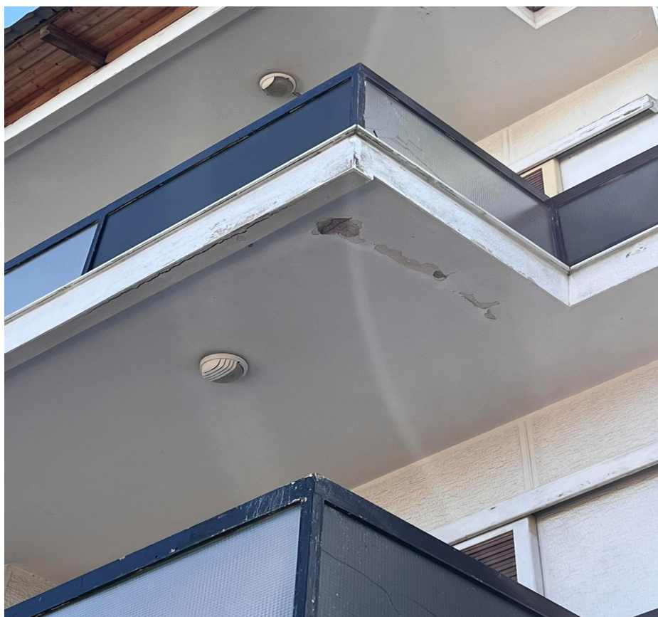
Εικόνα 9. Αποκόλλσεις στις πλάκες των εξωστών
