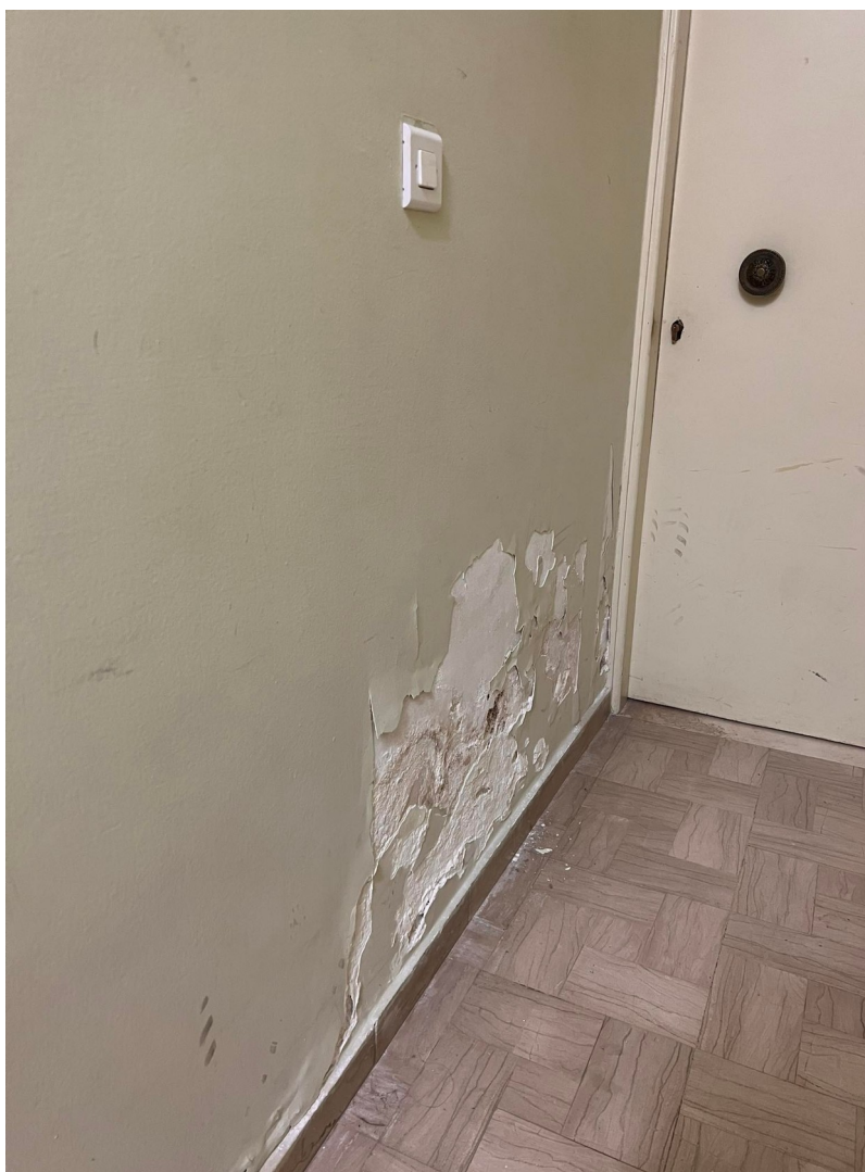
Εικόνα 10. Εσωτερικές υγρασίες.
