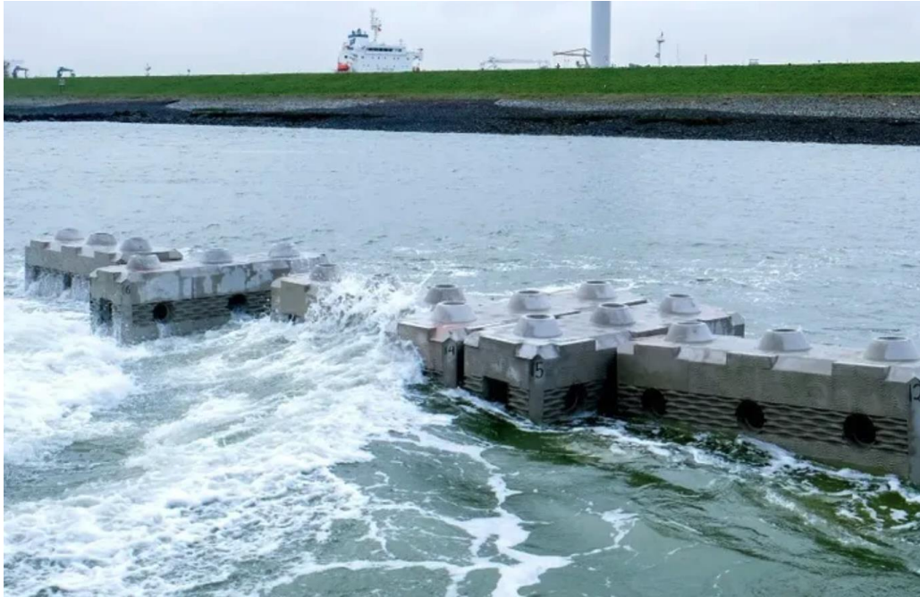
Εικόνα 3.5: Τεχνητοί ύφαλοι για την καταπολέμηση της διάβρωσης των ακτών [17]
