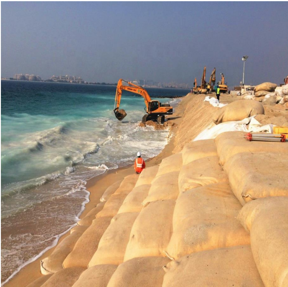
Εικόνα 3.6: Τοποθέτηση γεωυφάσματος για αναδιαμόρφωση παραλίας [18]
