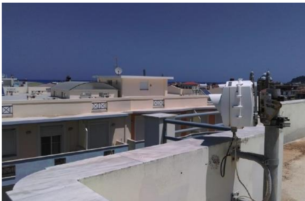
Εικόνα 4.16: Παράδειγμα οπτικού συστήματος εξωτερικού χώρου.
