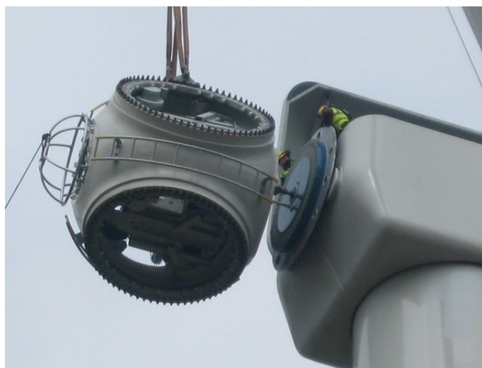
20. Εγκατάσταση ρότορα ανεμογεννήτριας
