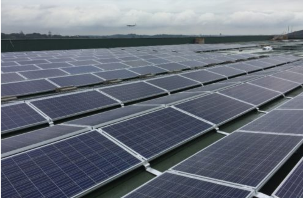
Εικόνα 2.2 Διάταξη ανατολής-δύσης σε ΦΒ πάρκο ( https://sunshine-energy.gr/ )
