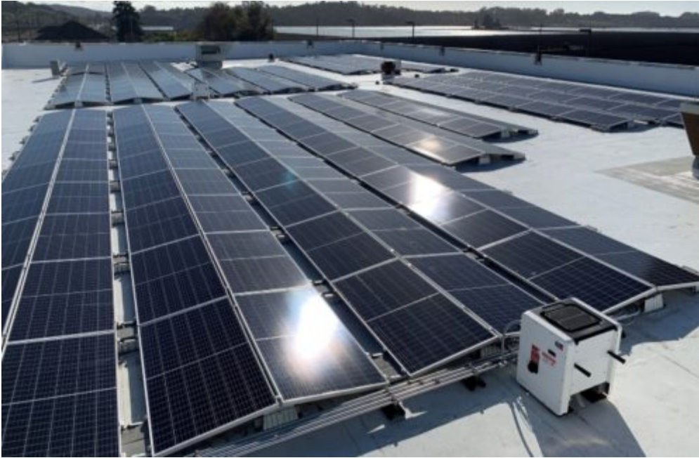
Εικόνα 2.3 Συστήματα ανατολής – δύσης σε ταράτσα ( https://sunshine-energy.gr/ )
