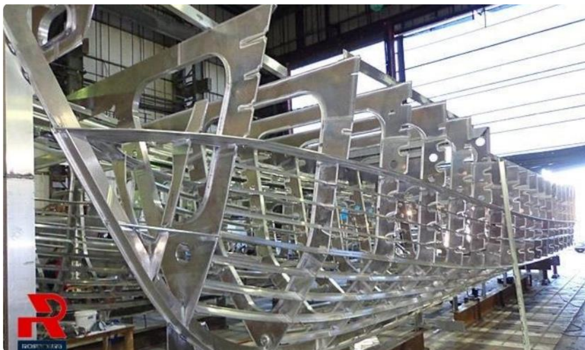
Εικόνα 5.4 : Κατασκευή σκελετού από κράμα αλουμινίου ( https://rosenburg.co )
