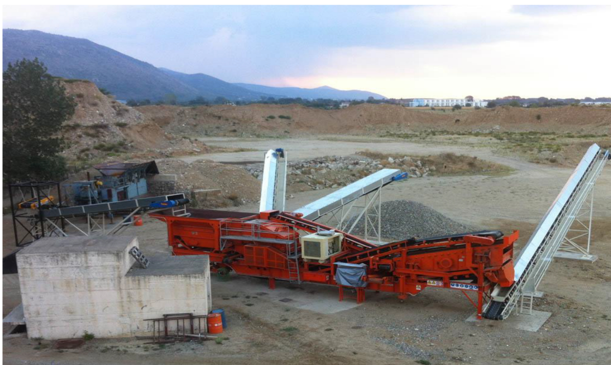
Εικόνα 13: Μεταφορικές ταινίες μονάδας διαχείρισης οικοδομικών αποβλήτων. (Κιουτουκτσης, 2017)
