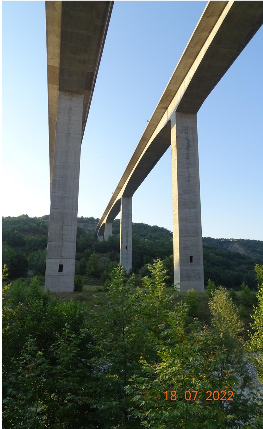
Εικόνα 16: Γέφυρα ποταμού Βενέτικου
