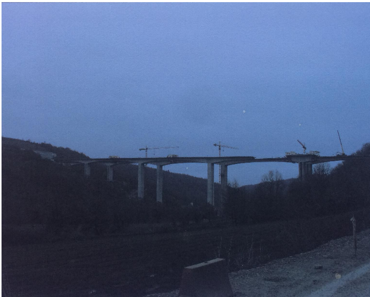
Εικόνα 25: Η μέθοδος της προβολοδόμησης στην γέφυρα του π.Βενέτικου
