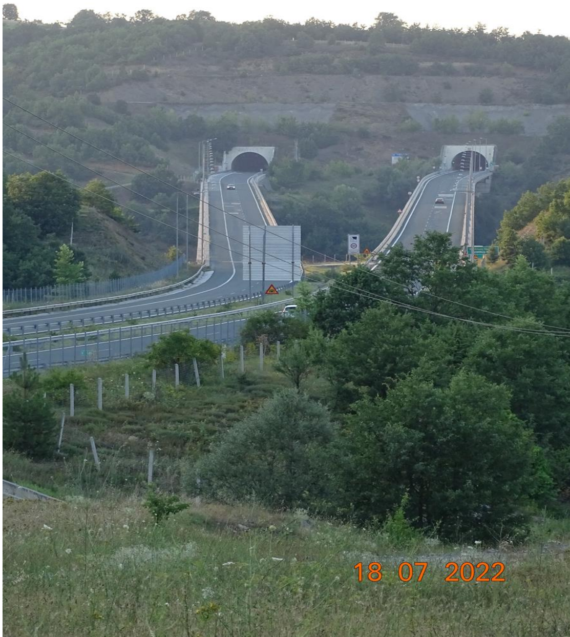
Εικόνα 30: Το κατάστρομα της γέφυρας του π.Βενέτικου μαζί με τις σήραγγες
