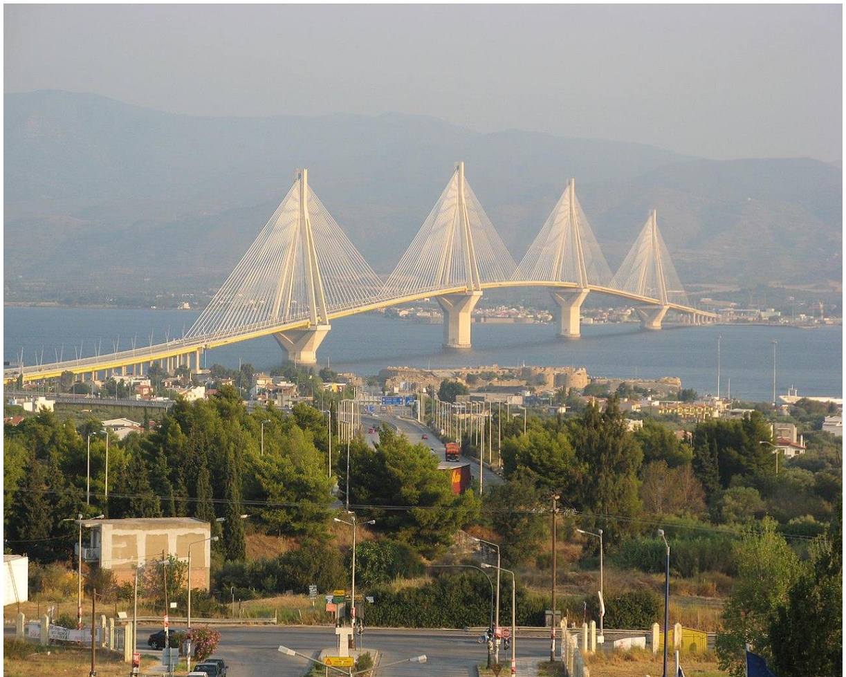
Εικόνα 5: Η γέφυρα Ρίου-Αντιρρίου ή “Χαρίλαος Τρικούπης”
