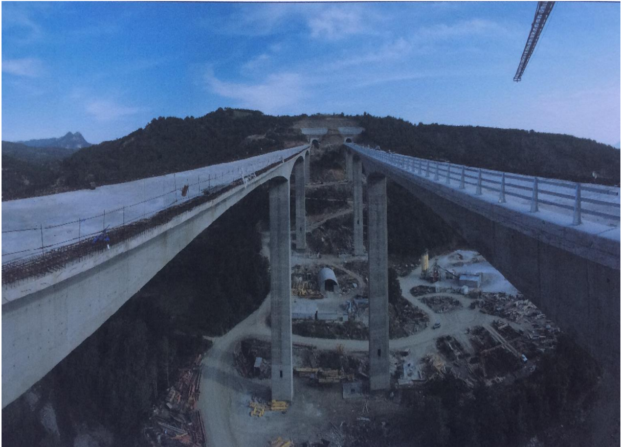
Εικόνα 29: Εργασίες στο κατάστρωμα της γέφυρας του π.Βενέτικου
