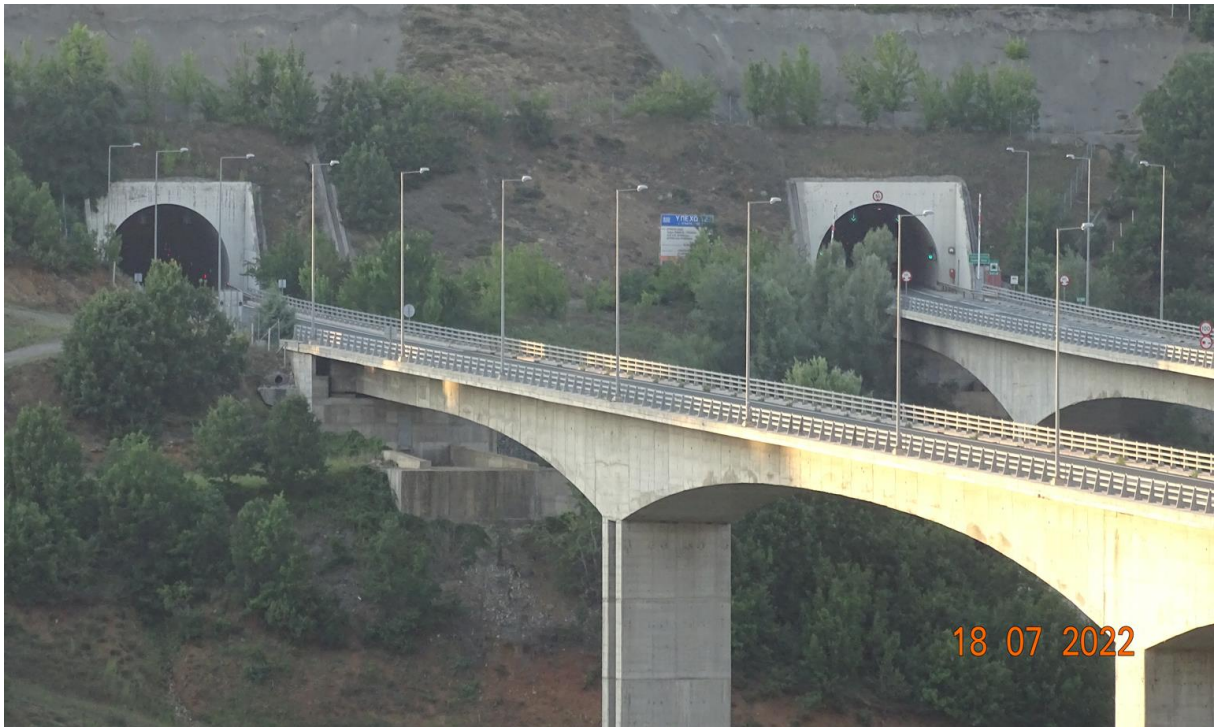
Εικόνα 31: Η γέφυρα του π.Βενέτικου σήμερα
