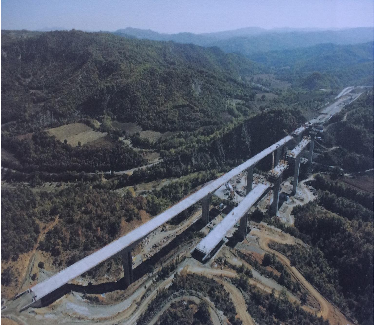
Εικόνα 28: Η γέφυρα του π.Βενέτικου υπό κατασκευή
