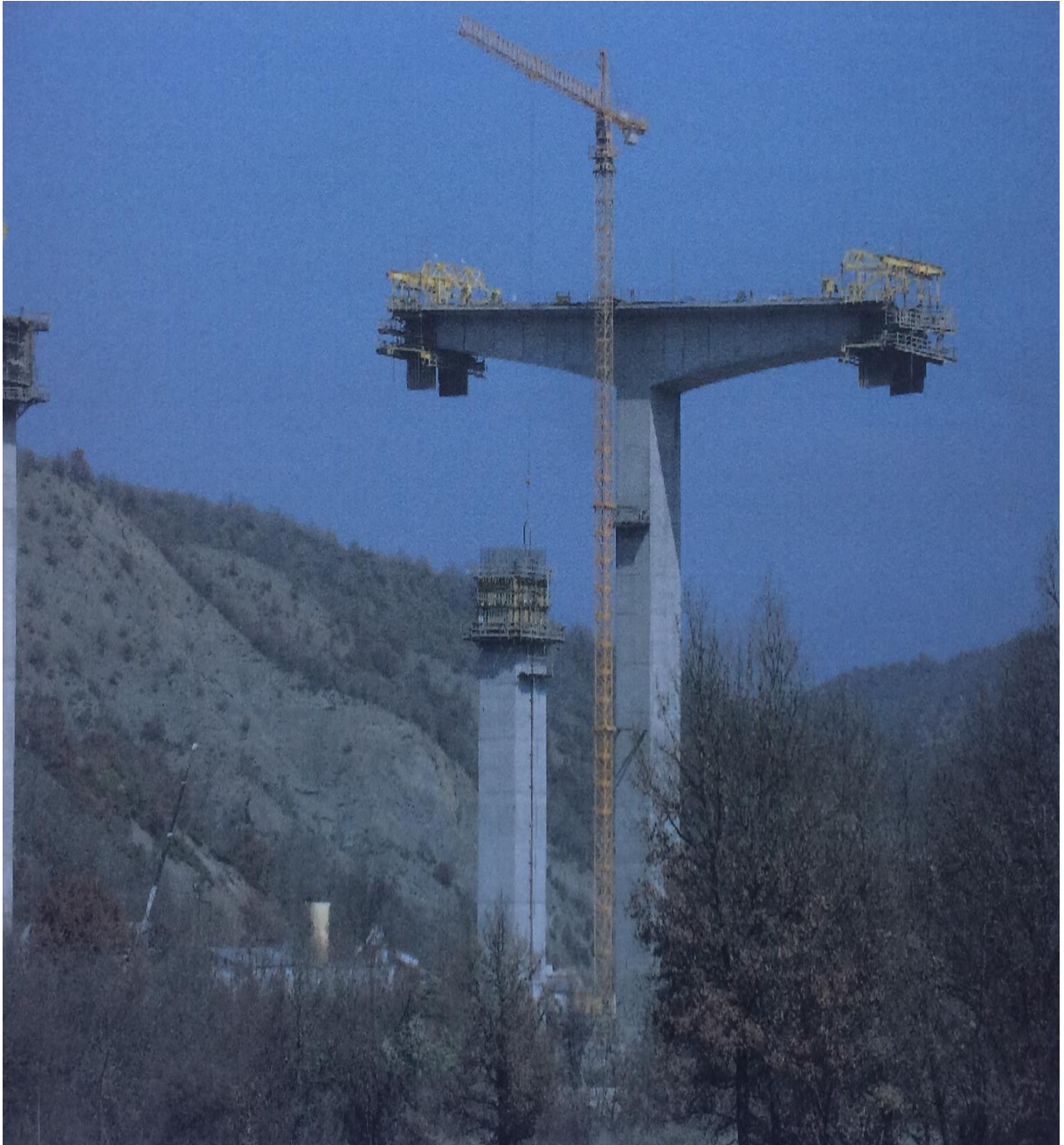
Εικόνα 21: Κατασκευή της γέφυρας του Βενέτικου ποταμού με την μέθοδο της προβολοδόμησης
