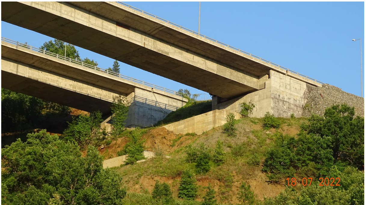
Εικόνα 24: Ακρόβαθρα της Γέφυρας π.Βενέτικου
