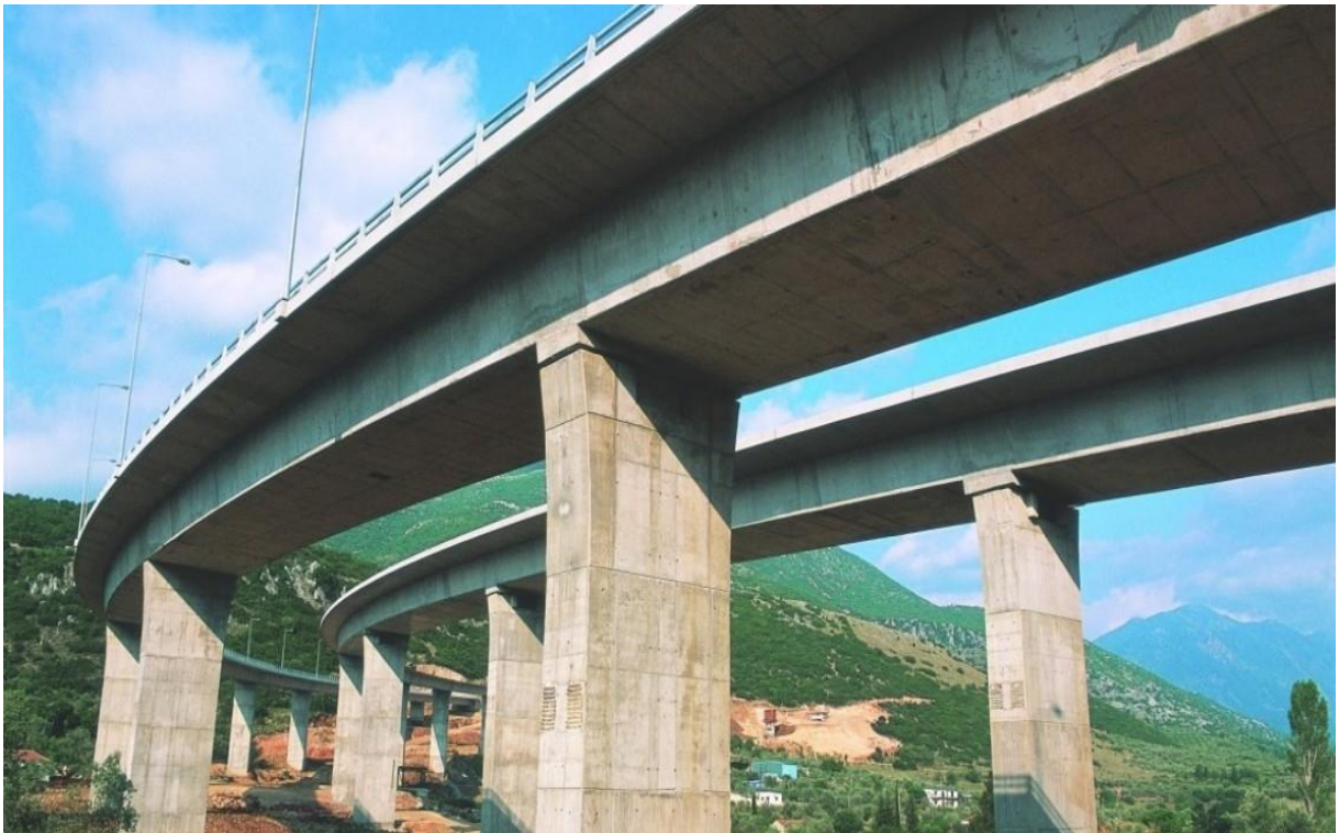
Εικόνα 7: Γέφυρα Κρυσταλοπηγής, Εγνατία οδός
