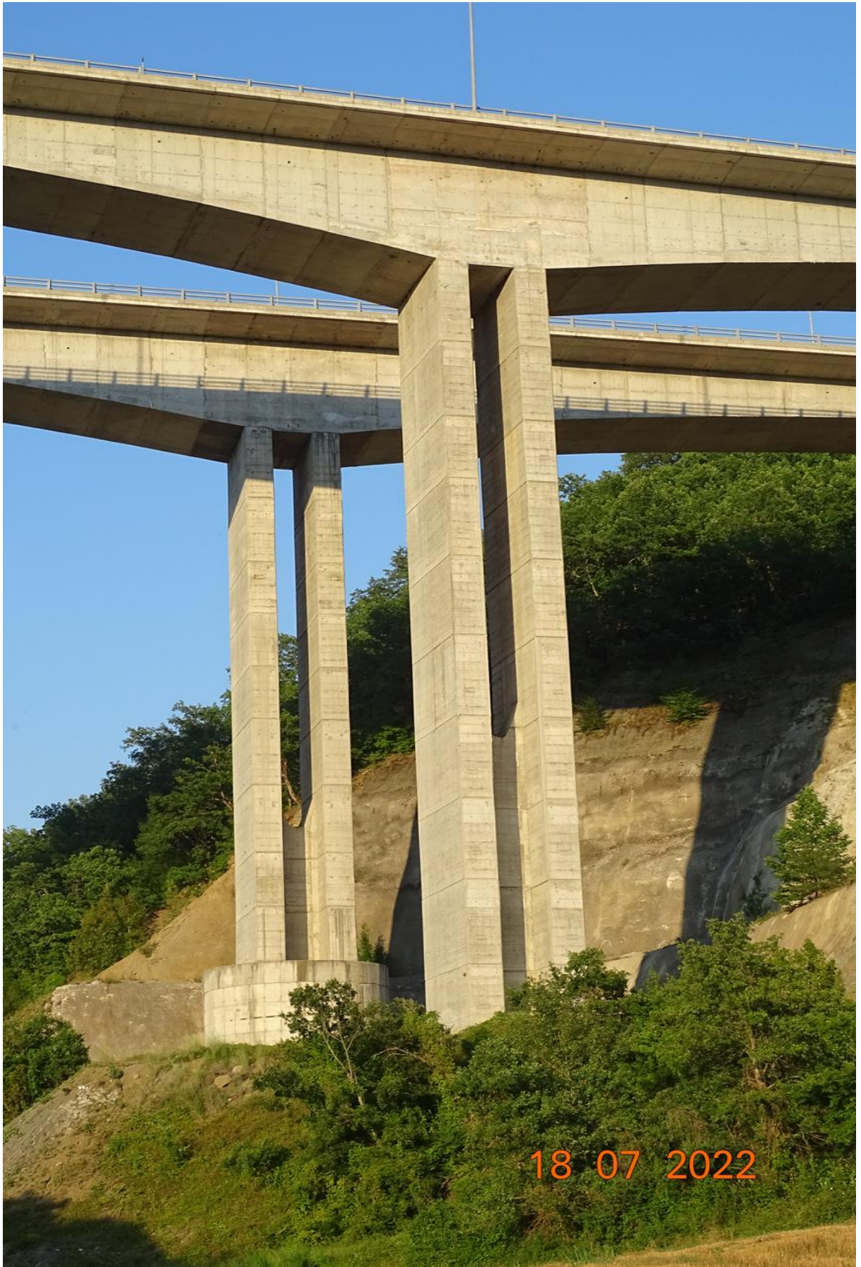
Εικόνα 22: Βάθρα της γέφυρας π.Βενέτικου
