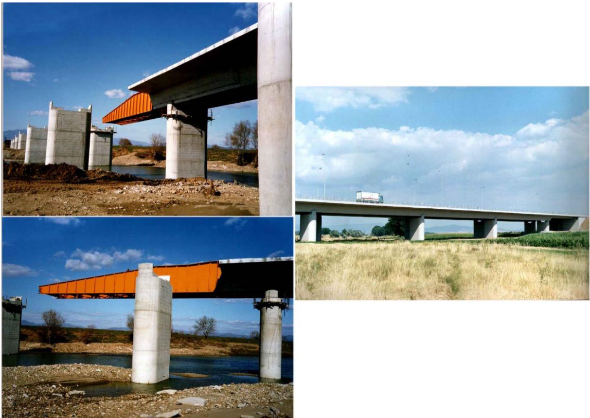
Εικόνα 8: Γέφυρα Ποταμού Φιλιουρή, Κομοτηνή, Εγνατία οδός
