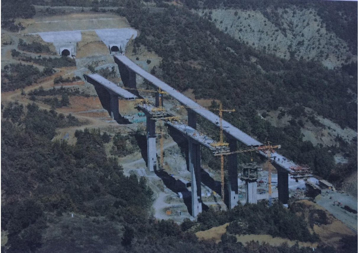
Εικόνα 27: Η γέφυρα του π.Βενέτικου υπό κατασκευή
