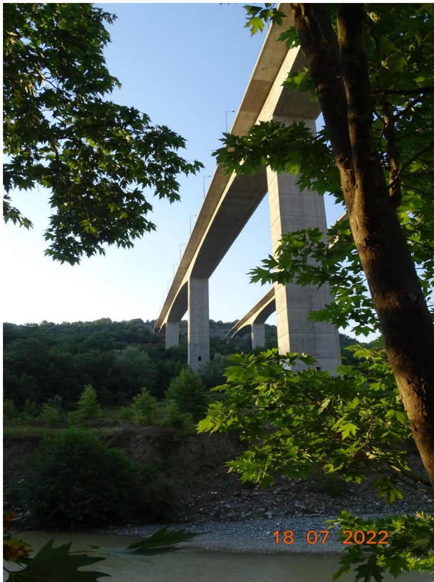
Εικόνα 15: Γέφυρα ποταμού Βενέτικου
