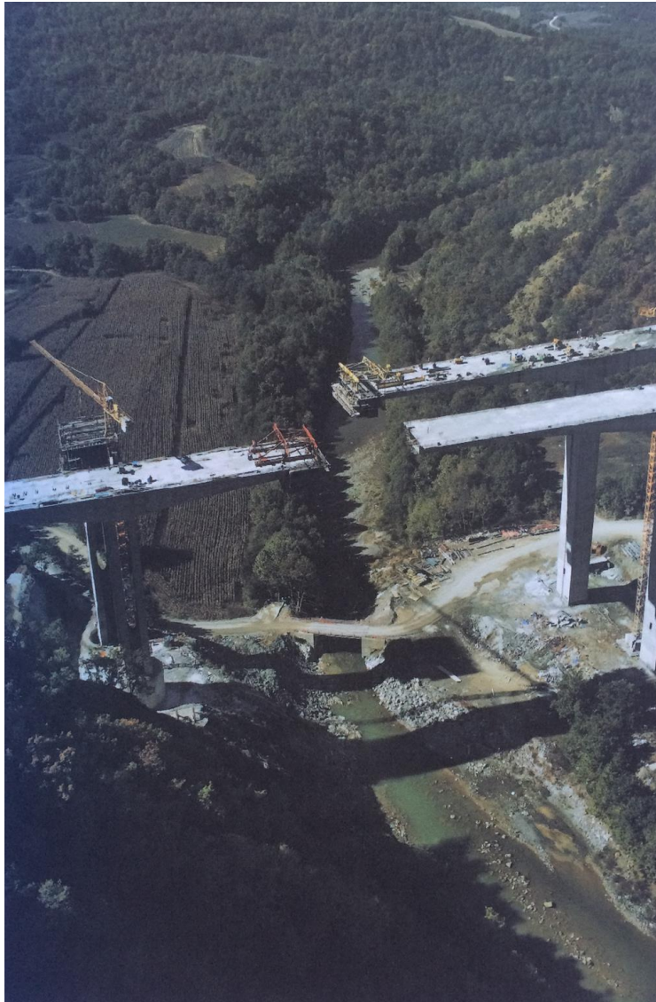
Εικόνα 26: Η γέφυρα του π.Βενέτικου υπό κατασκευή
