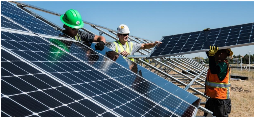
Εικόνα 2.9 Τοποθέτηση φωτοβολταϊκών πάνελ σε πάρκο ( https://www.edfenergy.com/energywise/renewable-energy-sources )
