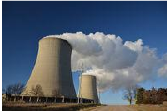
Εικόνα 2.8 Δύο πύργους ψύξης ενός πυρηνικού σταθμού. ( https://energyeducation.ca/encyclopedia/Nuclear_power_plant )
