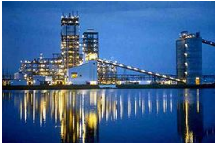
Εικόνα 4.1 Εργοστάσιο Tampa Electric IGCC στη Φλόριντα, ΗΠΑ ( https://netl.doe.gov/research/Coal/energy-systems/gasification/gasifipedia/igcc )
