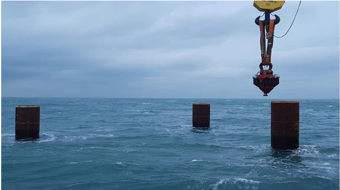
Εικόνα 4.4 Τελευταία βάση που τοποθετήθηκε από το σκάφος εγκατάστασης Bokalift στο υπεράκτιο αιολικό πάρκο East Anglia One στη Βόρεια Θάλασσα (Ηνωμένο Βασίλειο) https://www.iberdrola.com/about-us/our-activity/offshore-wind-energy/offshore-wind-park-construction
