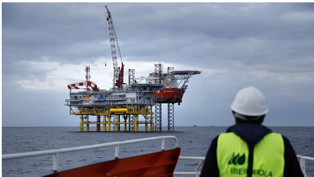
Εικόνα 4.1 Σκάφος υποστήριξης ανοικτής θαλάσσης (ξενοδοχειακό πλοίο) που συνδέεται με διαδρόμους με τον ηλεκτρικό υποσταθμό του υπεράκτιου αιολικού πάρκου Wikingen (Γερμανία) κατά τη διάρκεια ελιγμών θέσης σε λειτουργία ( https://www.iberdrola.com/about-us/our-activity/offshore-wind-energy/offshore-wind-park-construction )
