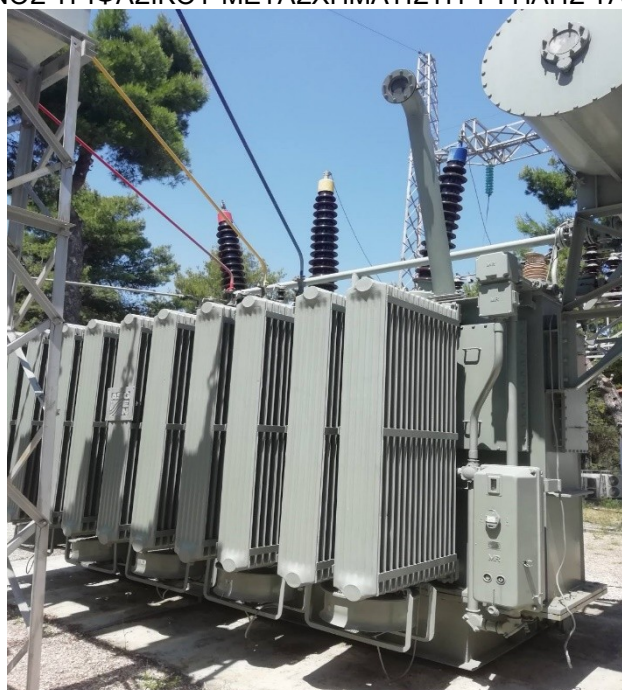
ΦΩΤΟΓΡΑΦΙΑ ΕΝΟΣ ΤΡΙΦΑΣΙΚΟΥ ΜΕΤΑΣΧΗΜΑΤΙΣΤΗ ΥΨΗΛΗΣ ΤΑΣΕΩΣ 150kV/20kV
