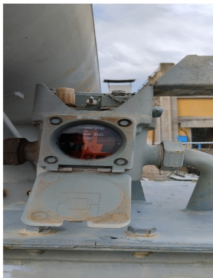
ΕΙΚΟΝΑ ΡΕΛΕ BUCHHOLZ ΕΝΟΣ ΑΥΤΟΜΕΤΑΣΧΗΜΑΤΙΣΤΗ
