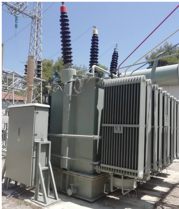
ΦΩΤΟΓΡΑΦΙΑ ΕΝΟΣ ΤΡΙΦΑΣΙΚΟΥ ΜΕΤΑΣΧΗΜΑΤΙΣΤΗ ΥΨΗΛΗΣ ΤΑΣΕΩΣ 150kV/20kV
