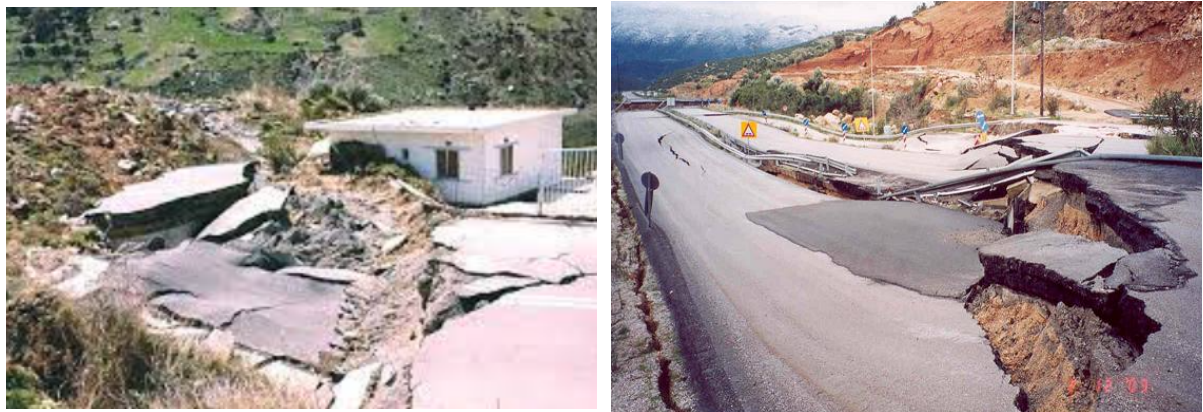
Εικόνα 10. Αστοχίες πρανών ( http://www.legah.metal.ntua.gr ).
