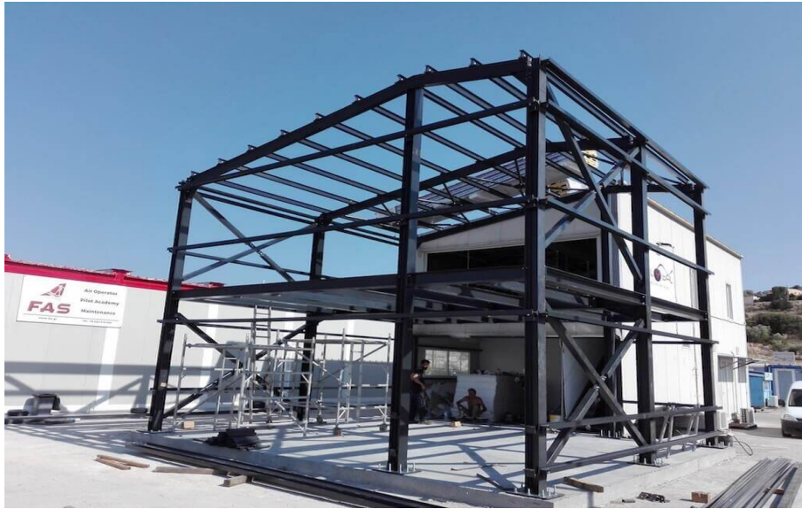
Εικόνα 8 Πρόσοψη ενός μεταλλικού κτηρίου [8]
