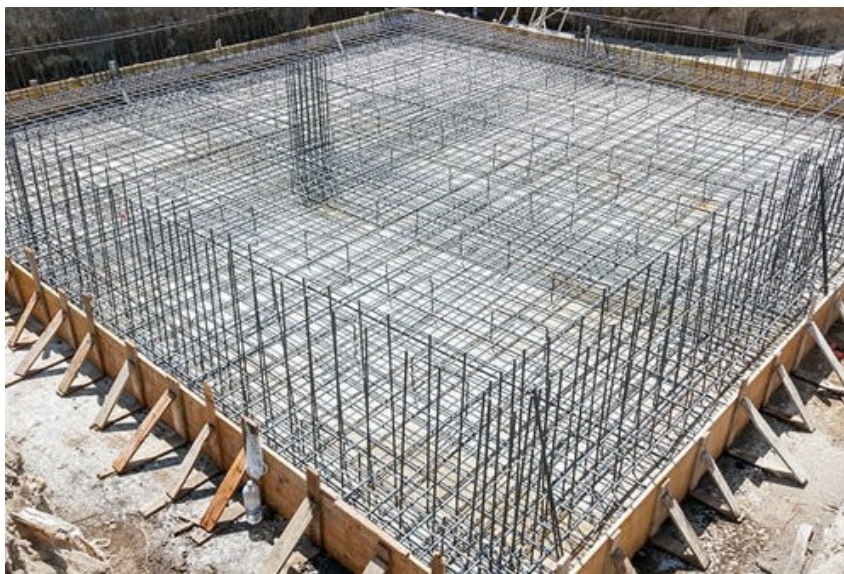
Εικόνα 7 Αντισεισμικός σχεδιασμός κτιρίου με την ύπαρξη πυκνού οπλισμού [8]
