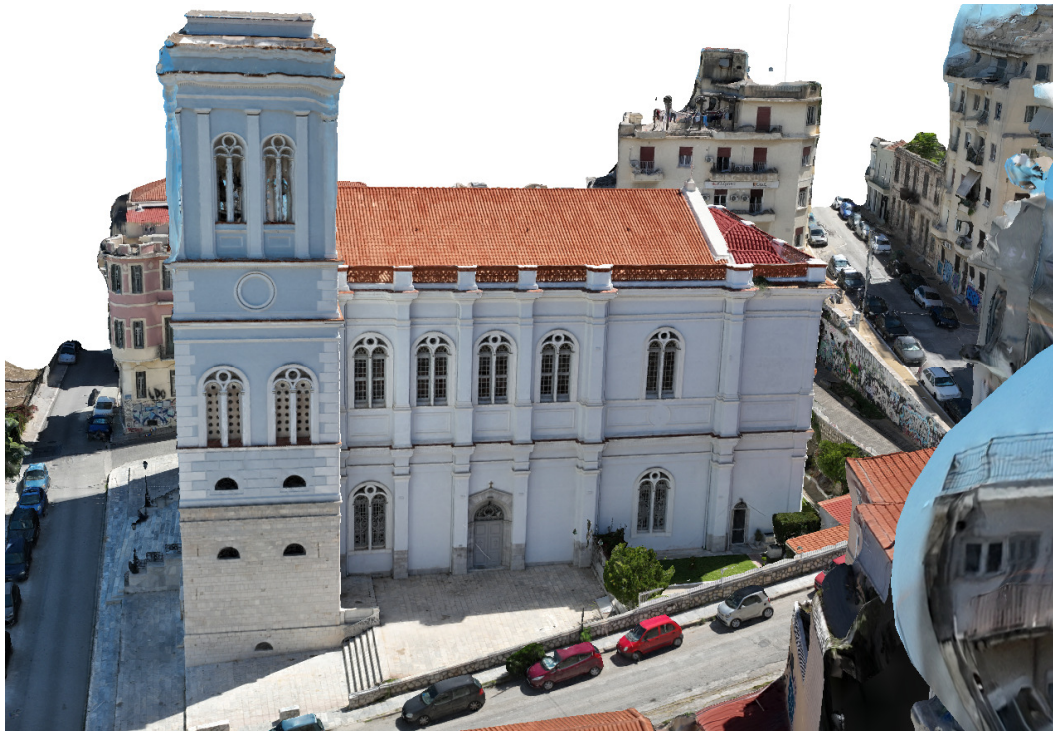
Εικόνα 41. Δεξιά πλάγια όψη εκκλησίας "Παντάνασσας".
