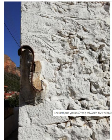
Εικόνα 4.14: Τοποθέτηση ελκυστήρα.
