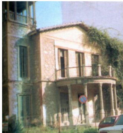
Εικόνα 2.15: Βλάστηση στην τοιχοποιία.
