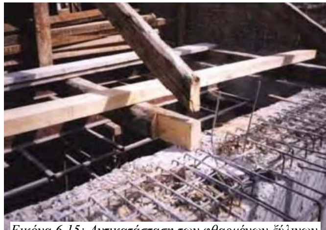
Εικόνα 6.15: Αντικατάσταση των φθαρμένων ξύλινων δοκών της στέγης.
