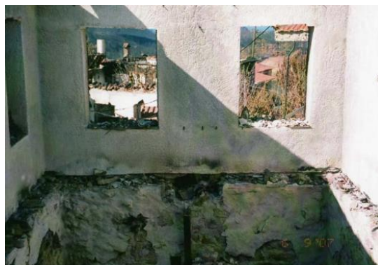
Εικόνα 2.6: Κατάρρευση στέγης και μέρος του ξύλινου δαπέδου, λόγω πυρκαγιάς σε νεοκλασικό κτήριο στην οδό Σταδίου 47, Αθήνα.
