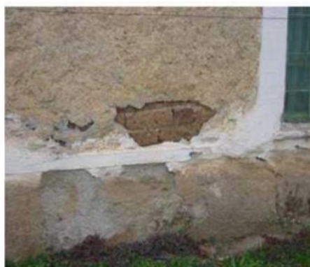
Εικόνα 2.11: Ανερχόμενη υγρασία.
