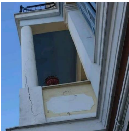
Εικόνα 2.2: Ρωγμές σε κτήριο στον Πειραιά μετά από ισχυρό σεισμό.
