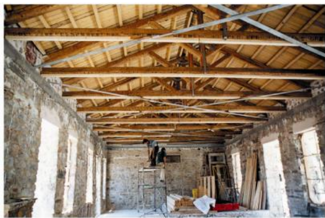
Εικόνα 5.3: Οριζόντιο διάφραγμα κάτω από ξύλινη στέγη.
