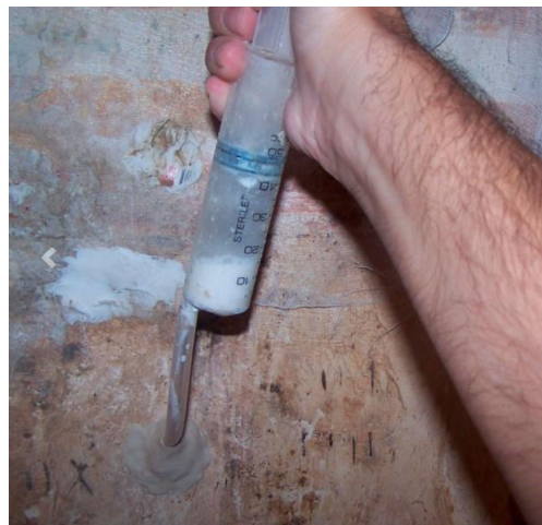
Εικόνα 4.19: Εισαγωγή στερεωτικού στο εσωτερικό τα τοιχοποιίας.
