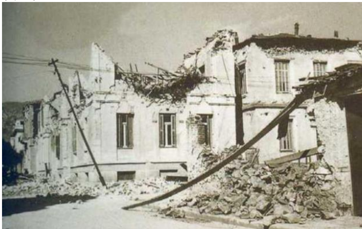
Εικόνα 2.1: Κατάρρευση τοίχων ορόφου σε κτήριο την δεκαετία του 1950 λόγω σεισμικών δονήσεων.
