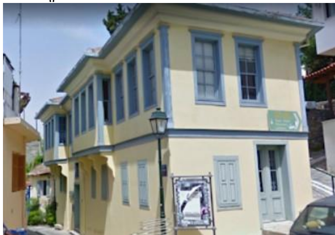
Εικόνα 6.1: Φωτογραφία του κτηρίου το 2019.
