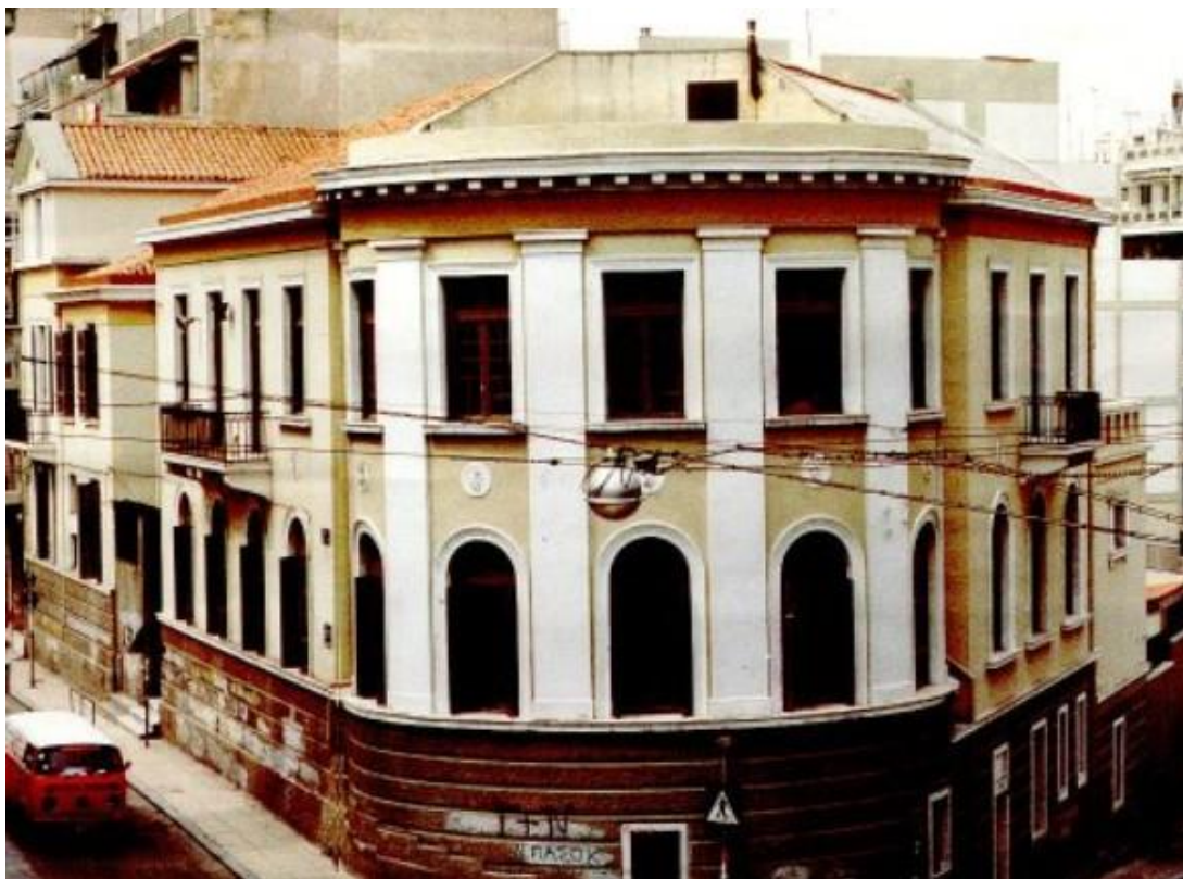
Εικόνα 6.13: Πρόσοψη του κτηρίου (πριν την αποκατάσταση του).
