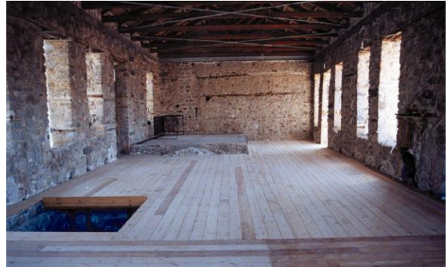
Εικόνα 5.8: Ενίσχυση διαφραγματικής λειτουργίας.
