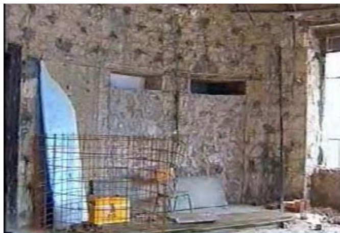
Εικόνα 6.16: Τοπική αποκατάσταση και συμπλήρωση τμημάτων της τοιχοποιίας.
