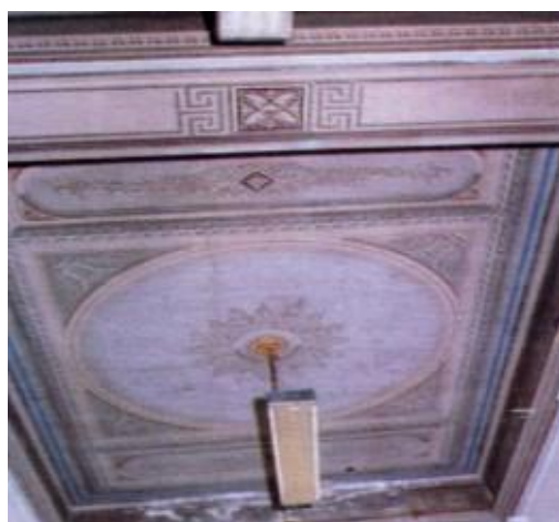
Εικόνα 4.17: Οροφोगραφία σε νεοκλασικό κτήριο στον Πειραιά.
