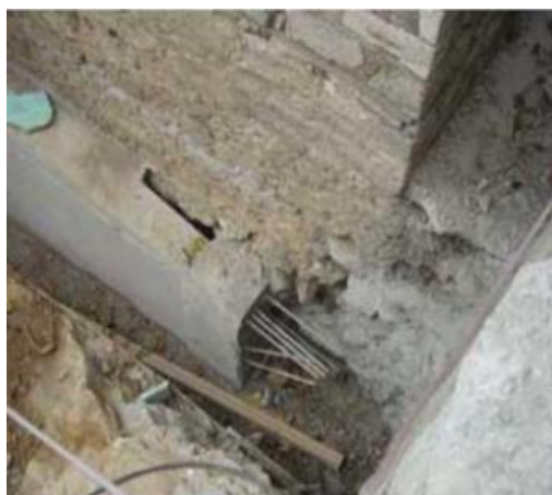
5.11: Ενισχύσεις θεμελίων περιμετρικής ζώνης από οπλισμένο σκυρόδεμα.
