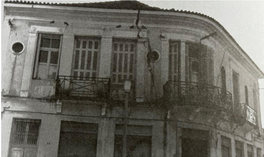
Εικόνα 2.4: Βλάβες στον όροφο του νεοκλασικού κτηρίου που έχουν προκριθεί από σεισμό.
