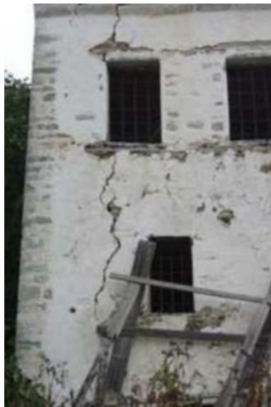
Εικόνα 2.17 : Ρωγμές στην ανωδομή λόγω καθίζησης.
