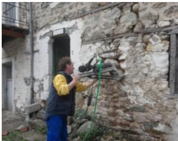
Εικόνα 3.5 : Συσκευή λήψης δοκιμίων σε υφιστάμενη τοιχοποιία.
