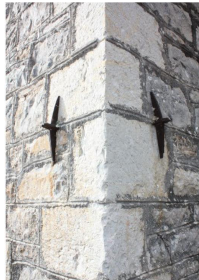
Εικόνα 4.13: Τοποθέτηση ελκυστήρα.
