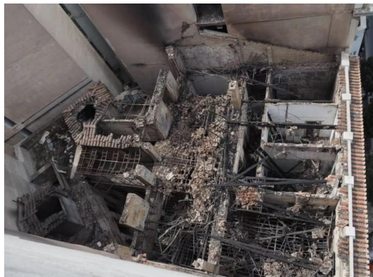
Εικόνα 2.6: Κατάρρευση στέγης και μέρος του ξύλινου δαπέδου, λόγω πυρκαγιάς σε νεοκλασικό κτήριο στην οδό Σταδίου 47, Αθήνα.
