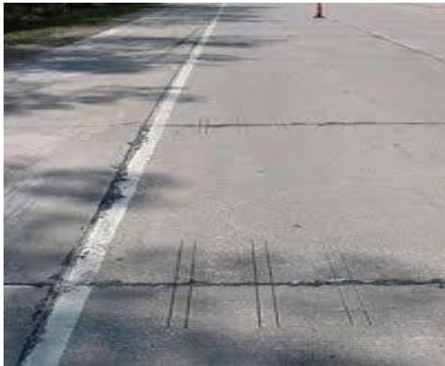
Εικόνα 11 : Εγκάρσιες ρωγμές .
