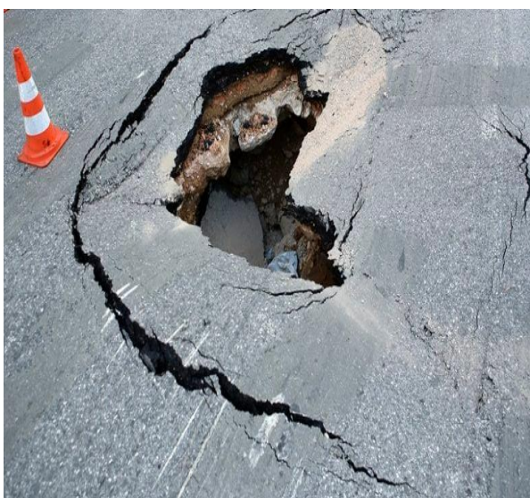
Εικόνα 33 : Καθίζηση οδοστρώματος.
