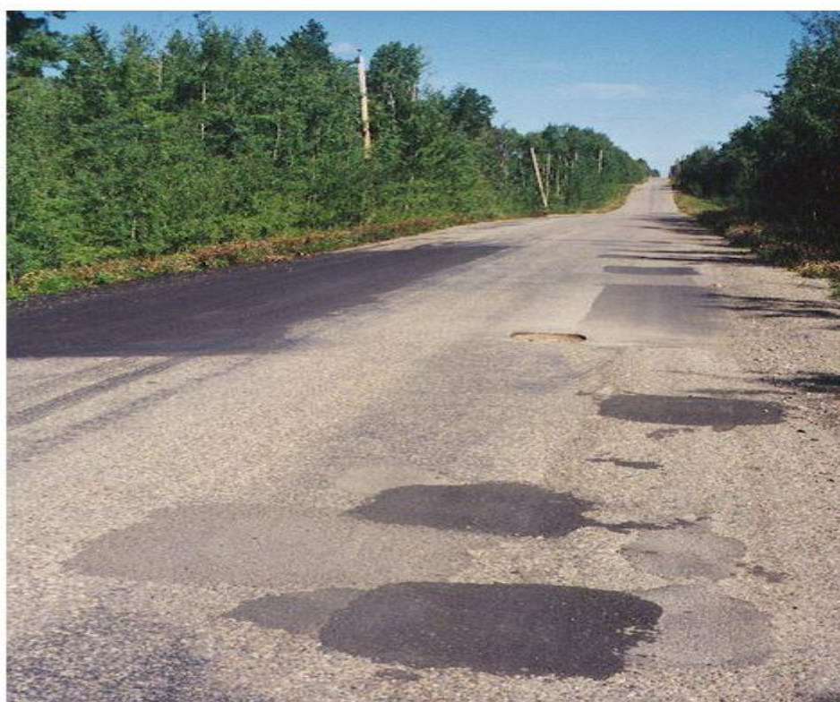
Εικόνα 25 : Τοπική επικάλυψη σε φθορά.
