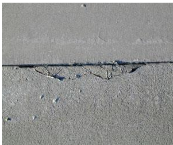
Εικόνα 34 :Θρυμματισμός πλακών.
