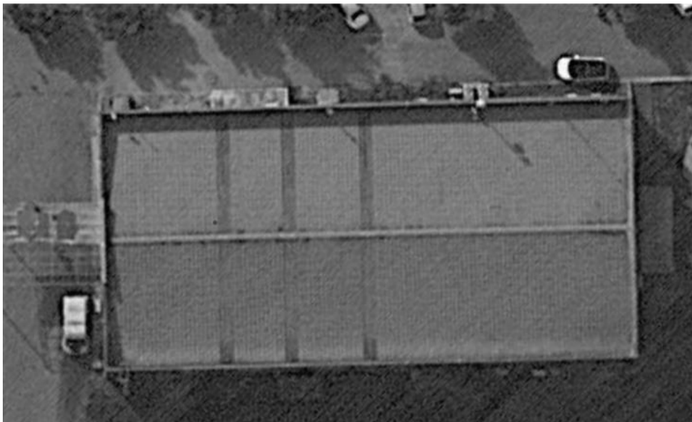
3.2 Κάτοψη βιομηχανικής στέγης από δορυφόρο.
