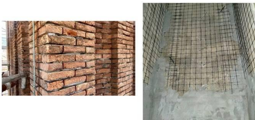
Εικόνα 23: Μεταλλικά Πλέγματα ( https://shellmarconstruction.co.uk/brickwork-and-blockwork )
