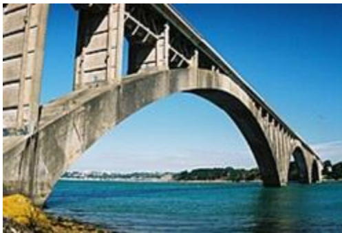
Εικόνα 39 Η γέφυρα Plougastel,
