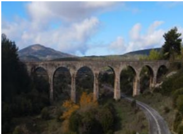
Εικόνα 37 Γέφυρα Μάναρη διατηρητέο μνημείο του οραματισμού του Χαρίλαου Τρικούπη που πίστευε πολύ στον σιδηρόδρομο
