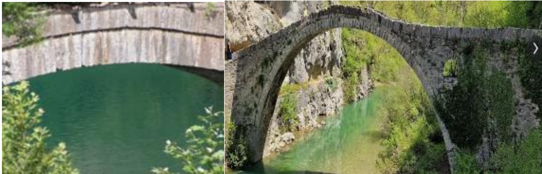
Εικόνα 46 Θολίτες και Τρόπος Δόμησης του Τόξου με Συμμετρική Τοποθέτηση από τις Δύο Πλευρές γεφυρι Κόκκορη
