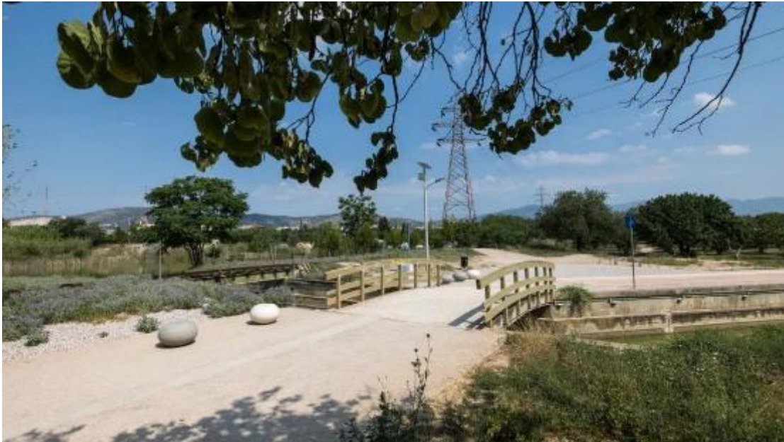
Εικόνα 54 Ανάπλαση ιστορικής γέφυρας και ένταξη στο περιβάλλον. Μητροπολιτικό Πάρκο «Αντώνης Τρίτσης» στο Ίλιον Αττικής
