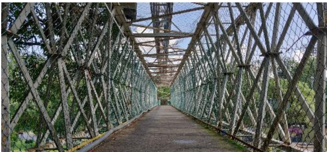
Εικόνα 53 γέφυρα του Ευρώτα (γνωστή και ως γέφυρα της Σκάλας) στη Λακωνία γέφυρα έχει μια στενή διάβαση για πεζούς, περιτριγυρισμένη από μεταλλικό δικτυωτό πλέγμα
