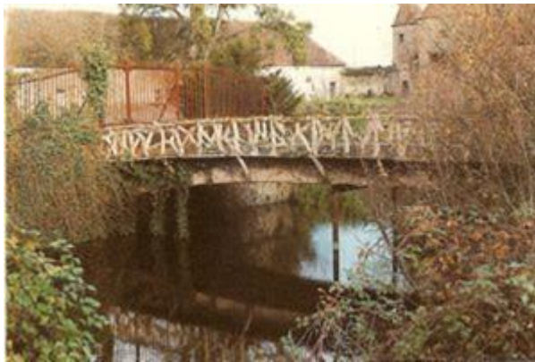
Εικόνα 36 Η κατασκευή της πρώτης γέφυρας πραγματοποιήθηκε το 1875 από τον Joseph Monier
