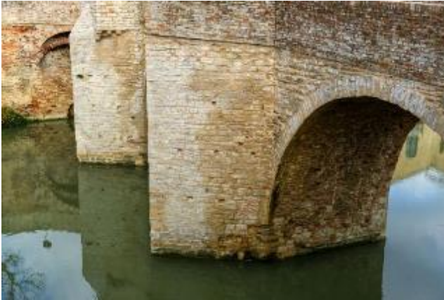
Εικόνα 28 Γέφυρας του Τιβέριου (Ponte di Tiberio)
