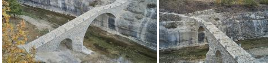
Εικόνα 51 Γέφυρα της Σβόλιανης (ή Γεφύρι της Αγίας Σωτήρας), βρίσκεται στην περιοχή του Βοΐου, στο νομό Κοζάνης
