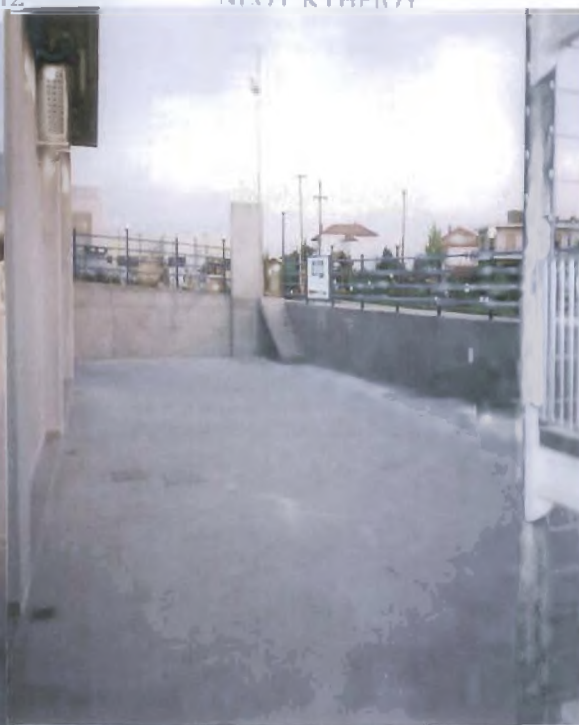
Ο ΧΩΡΟΣ ΣΤΑΘΜΕΥΣΗΣ ΤΟΥ ΣΥΝΕΤΑΙΡΙΣΜΟΥ ΣΤΟ ΝΕΟ ΚΑΤΑΣΤΗΜΑ
