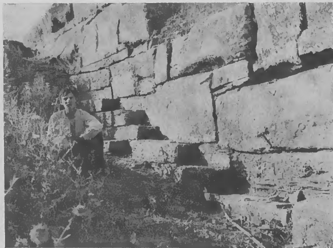
Abb. 84. Die nordöstliche Seitenmauer der Stoaterrasse, von Nordwesten gesehen. — 1935.
