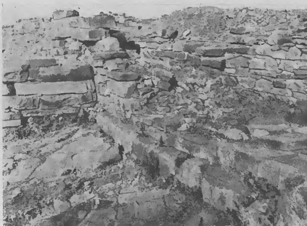
Abb. 59. Oben rechts moderne Trockenmauer; in der Mitte die Terrassenmauer für den Bau D, sowie über und links von ihr Mauerwerk vom Bau F. — 1935.
