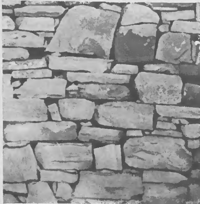
Abb. 257. Moderne Trockenmauer auf dem Laphrionhügel.
