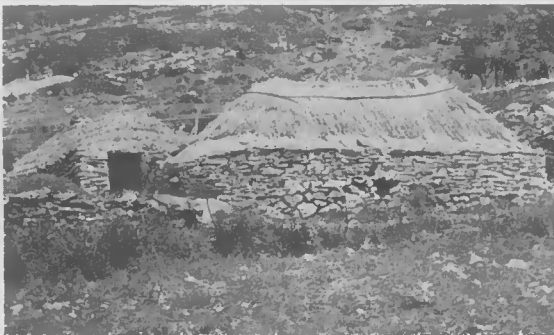
Abb. 304. Aitolisches Haus (s. Grundriss u. Schnitt, Abb. 298) mit primitivem Knickdach. — Phot. E. D. 1939.
