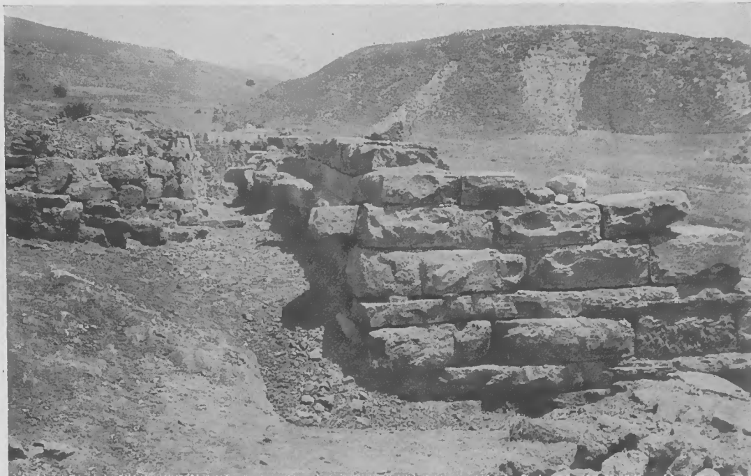
Abb. 64. Bau F, von Südwesten gesehen. Im Hintergrund links Bau D. — 1926.
