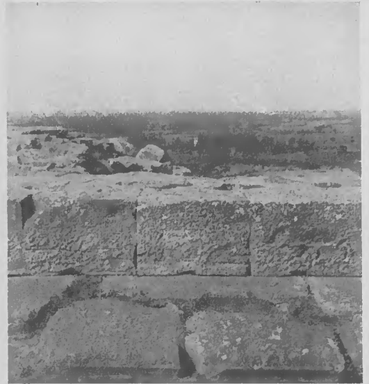
Abb. 48. Links im Hintergrunde Porosblöcke (Ausgleichslage für den Cellaboden), rechts Toichobatblöcke. Beachte die Sprengkeillöcher. — 1935.
