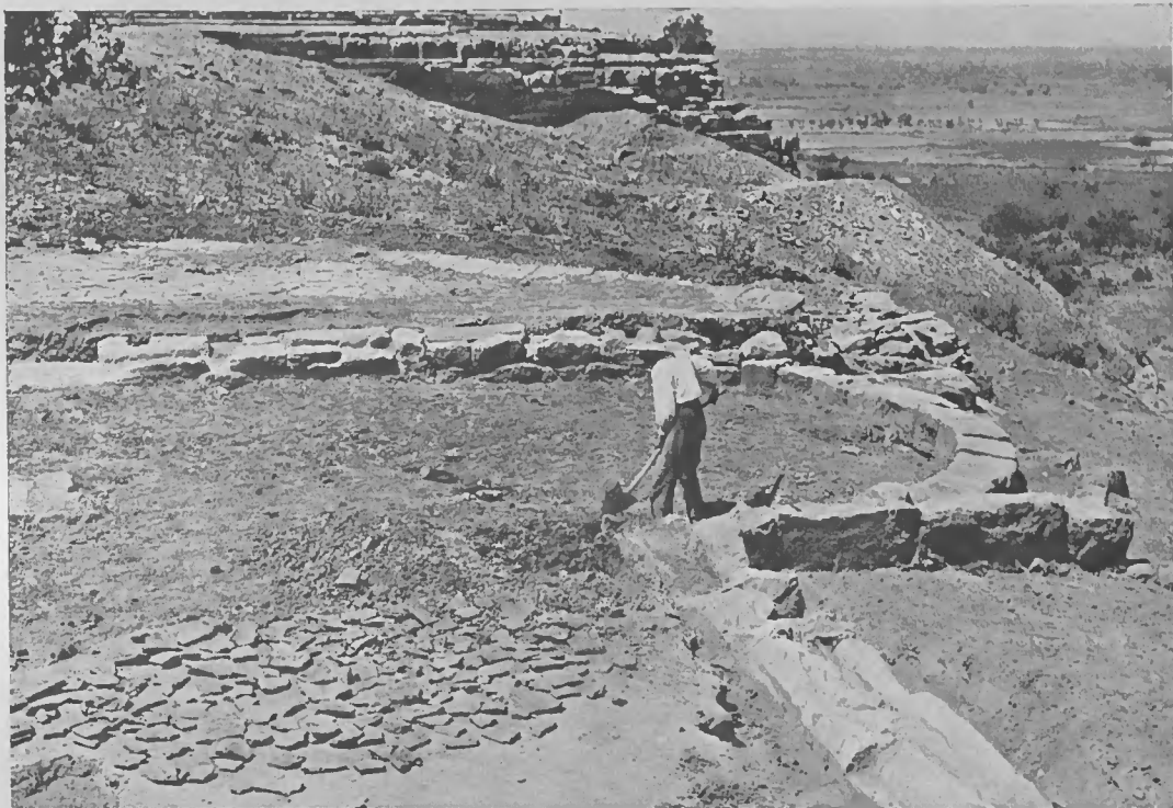
Abb. 80. Südwestlicher Teil der Stoa, von Nordosten gesehen. Im Hintergrunde Terrasse des Tempels B. 1926.
