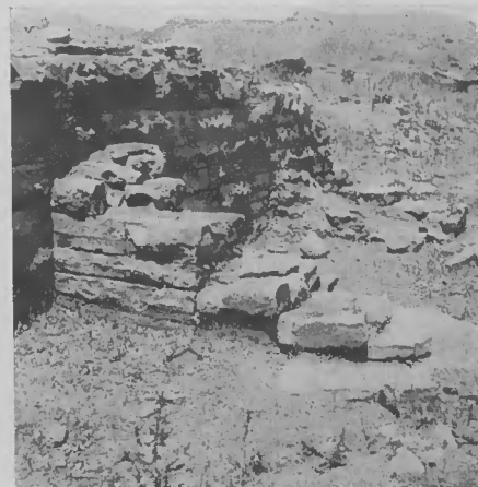
Abb. 60. Rest des mittleren Strebepfeilers und von anstossendem späteren Mauerwerk. — 1935.
