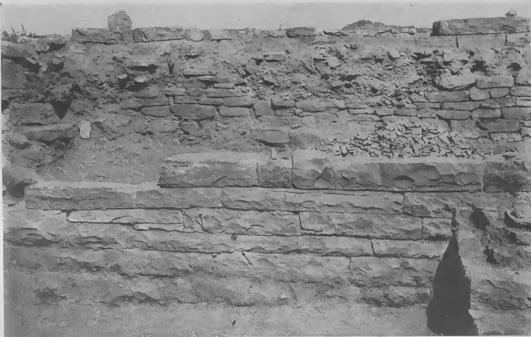
Abb. 58. Bau F, von Südosten gesehen. Oben: Terrassenmauerwerk für den Bau D. — 1926.
