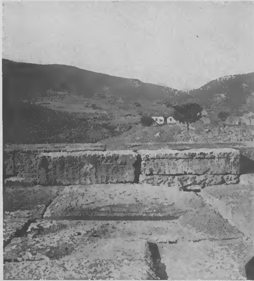
Abb. 48. Links im Hintergrunde Porosblöcke (Ausgleichslage für den Cellaboden), rechts Toichobatblöcke. Beachte die Sprengkeillöcher. — 1935.
