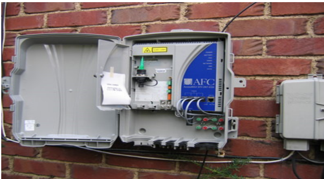
Εικόνα 3.15 – ONT εξωτερικού χώρου σε FTTB υποδομή
