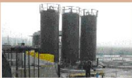
Φωτογραφία από τις εργασίες κατασκευής του εργοστασίου παραγωγής βιοκαυσίμων της ΕΛΙΝΟΙΛ στον Βόλο, που πρόκειται να τεθεί σε λειτουργία το φθινόπωρο
