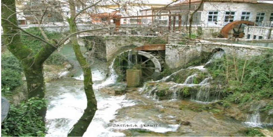
ΣΧΗΜΑ 19:ΝΕΡΟΜΥΛΟΙ ΣΕ ΠΑΛΙΟ ΒΙΟΜΗΧΑΝΙΚΟ ΚΤΙΡΙΟ ΚΛΩΣΤΟΥΦΑΝΤΟΥΡΓΙΑΣ
