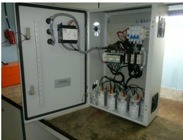
Εικόνα 21: Πίνακας πυκνωτών αντιστάθμισης
