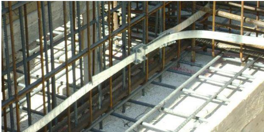
Εικόνα 40: Ισοδυναμικό πλέγμα
