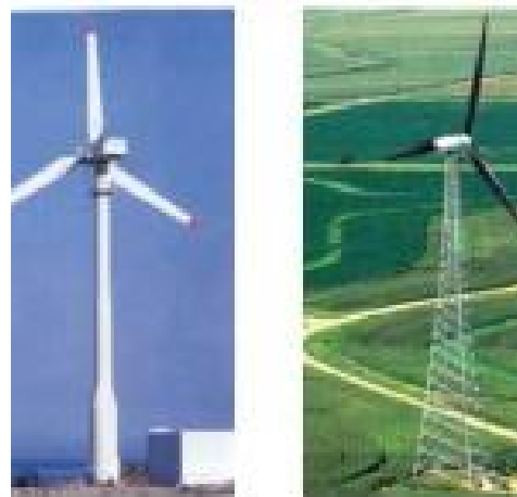
Σχήμα2.7: Α/Γ με σωληνωτό χαλύβδινο πύργο (αριστερά) και δικτυωτό πύργο (δεξιά)
